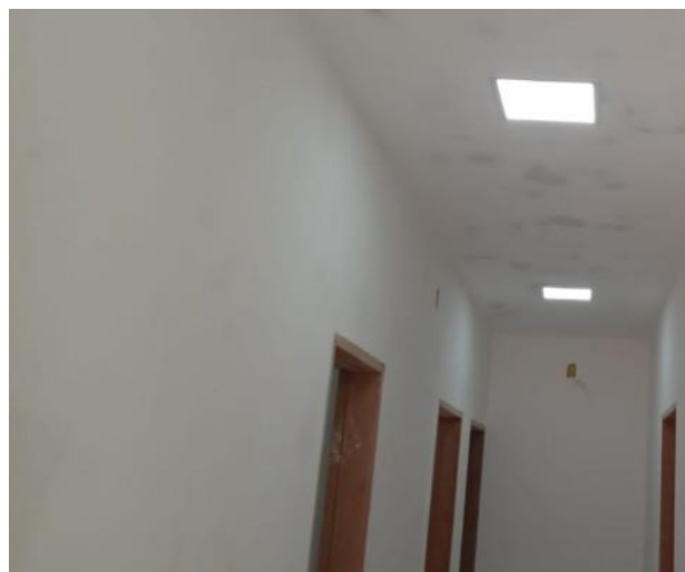
Foto 04 – Instalação das luminárias.
