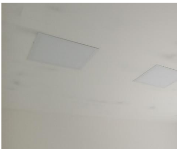
Foto 03 – Instalação das luminárias..
