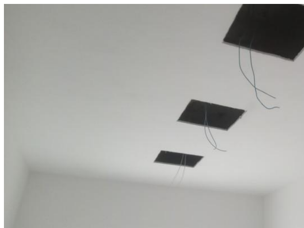
Foto 02 – Instalação das luminárias.
