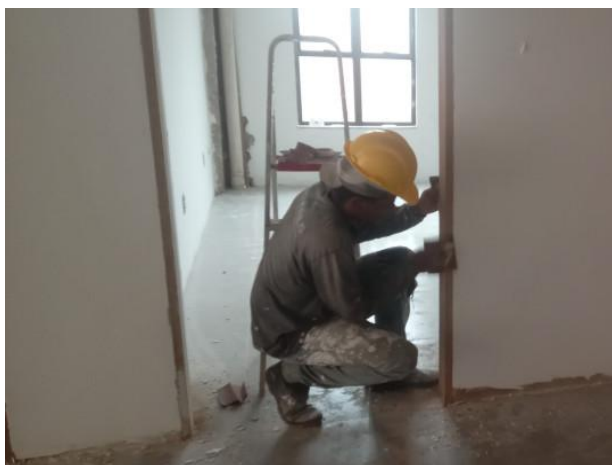
Foto 01 – Instalação das portas.
