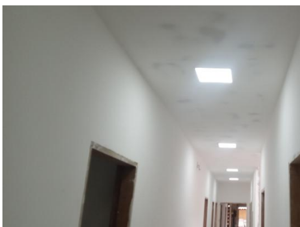
Foto 05 – Instalação das luminárias.
