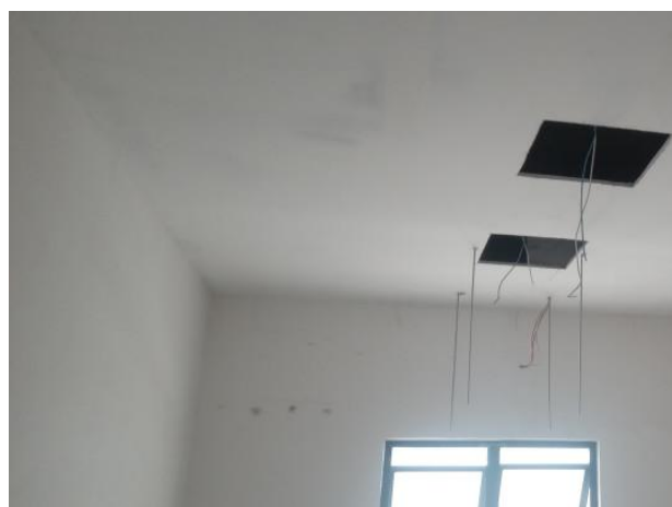
Foto 06 – Instalação das luminárias.
