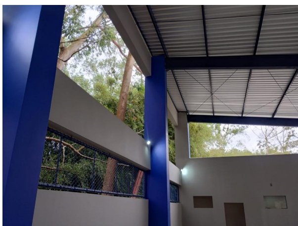
Foto 05 – Pintura das vigas e pilares da quadra.
