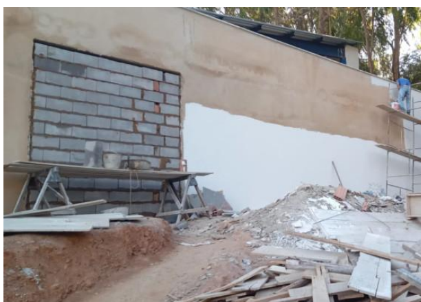
Foto 03 – Pintura de alvenaria nos fundos da quadra.
