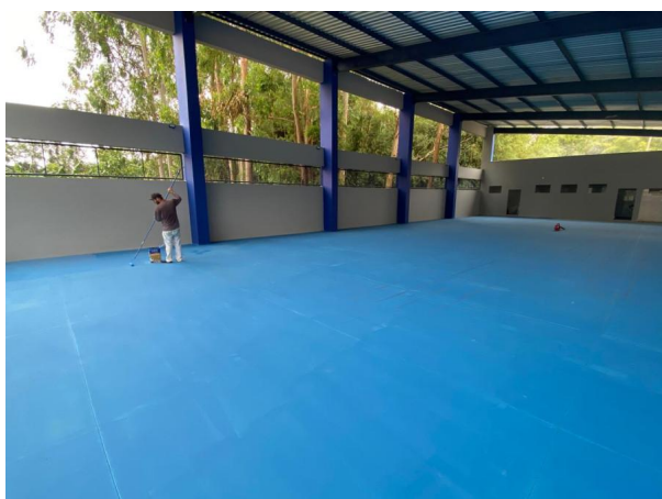
Foto 07 – Pintura de fundo do piso da quadra.
