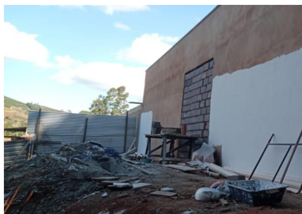
Foto 04 - Pintura de alvenaria nos fundos da quadra.
