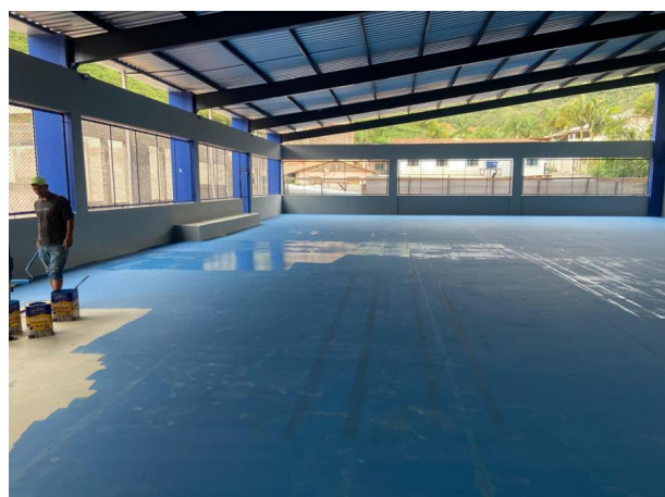
Foto 06 – Pintura de fundo do piso da quadra.
