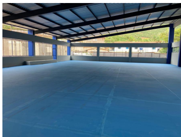
Foto 08 – Pintura de fundo do piso da quadra.
