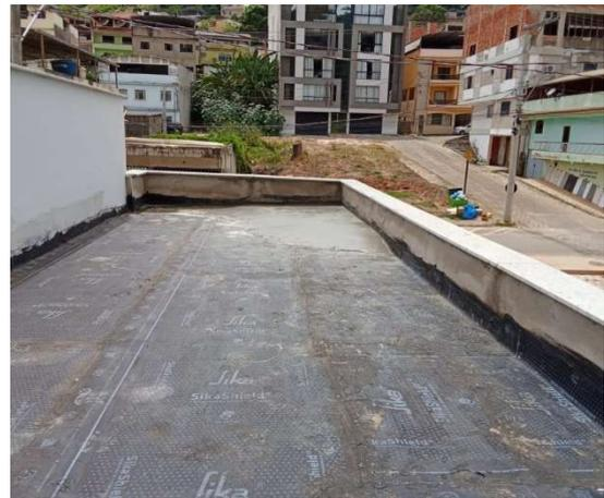
*Foto 20 – Reparos na impermeabilização sobre a laje da cobertura.*
