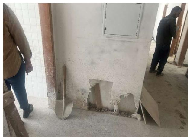
Foto 04 - Reparos em paredes decorrente da execução do granilite.
