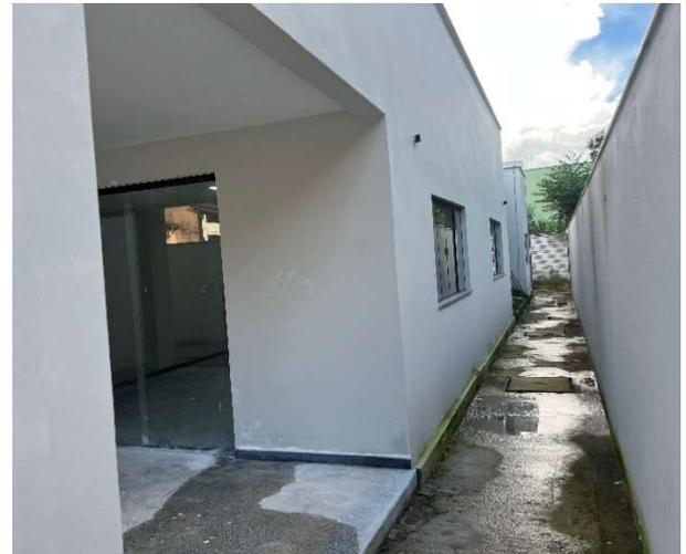
*Foto 18 – Retoque na pintura externa das paredes.*
