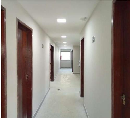
*Foto 21 – Arremates na pintura e emassamento das paredes e teto.*
