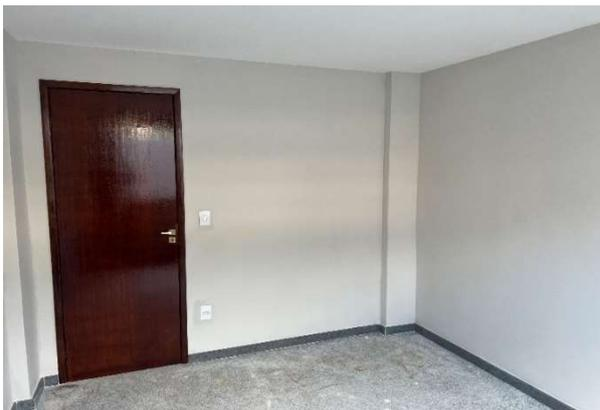
*Foto 15 – Pintura em verniz nas portas e retoque na pintura das paredes.*
