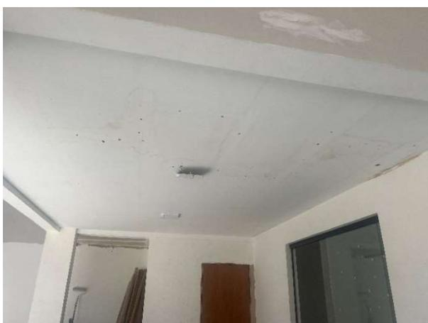
Foto 03 - Reparo no teto e parede. Correção de infiltração da laje e cobertura.
