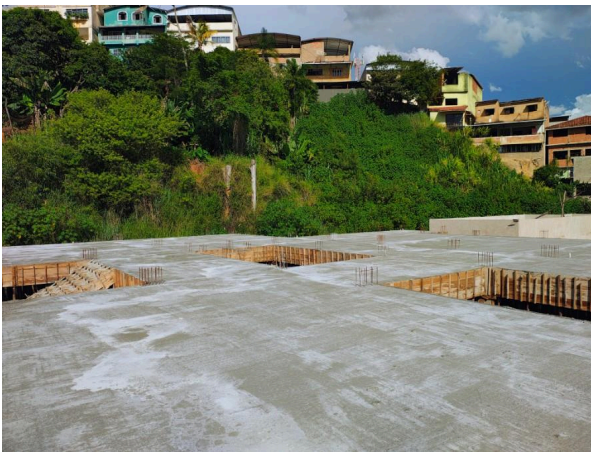
Foto 01 – Concretagem Lajes e Vigas.
