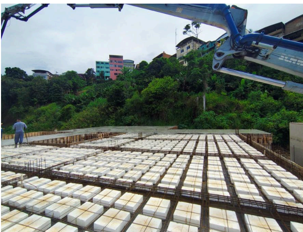
Foto 03 – Concretagem lajes e vigas.
