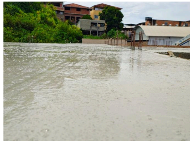
Foto 02 – Concretagem de lajes e vigas.
