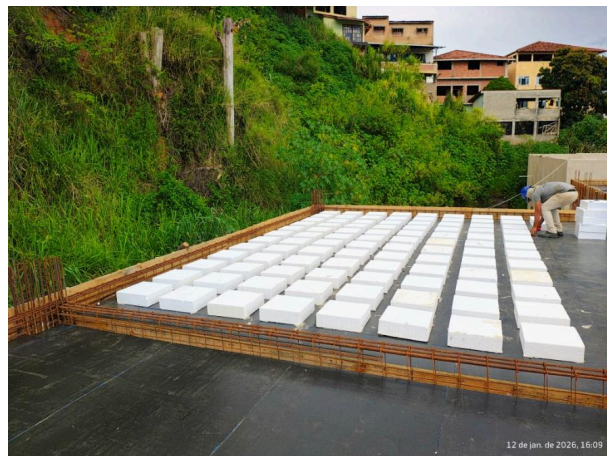
Foto 06 – Fôrmas de lajes.
