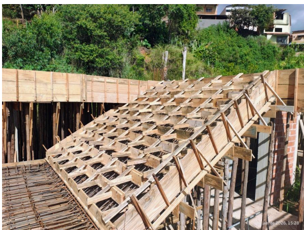
Foto 07 – Formas e armaduras da escada.
