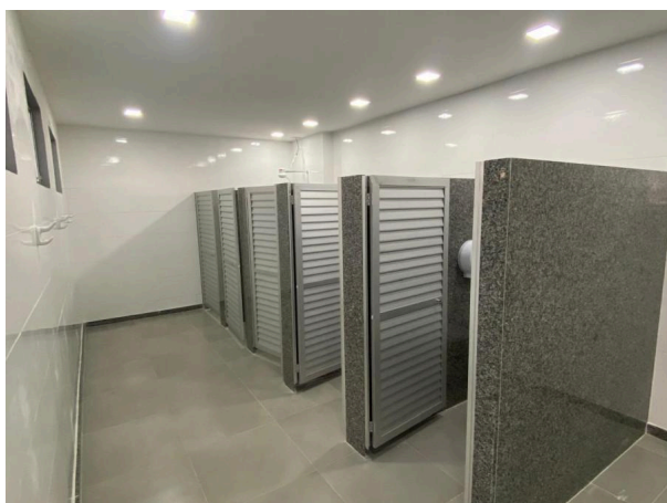
Foto 05 – Instalação das portas dos banheiros dos vestiários.
