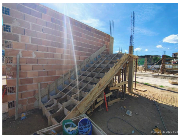
Foto 04 – Forma para concretagem de escada.
