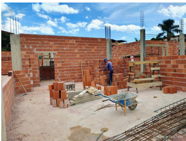
Foto 07 – Execução de alvenaria.
