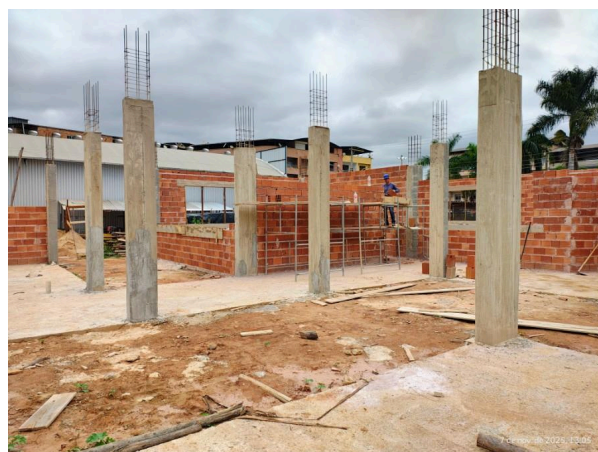
Foto 02 – Concretagem dos pilares.
