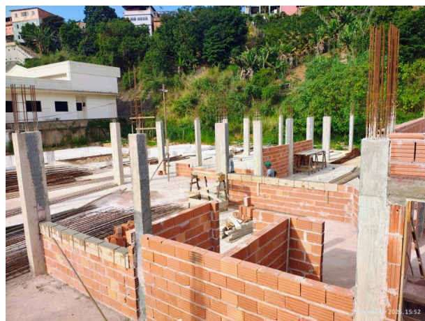
Foto 08 – Execução de contra-verga dos vãos das janelas.
