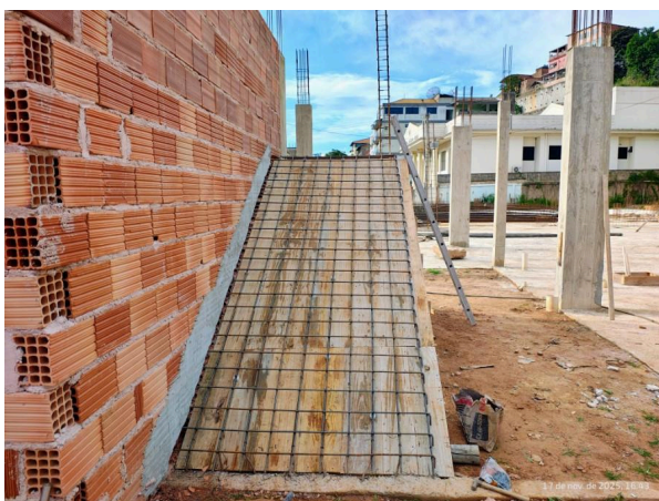
Foto 03 – Armação para concretagem de escada.
