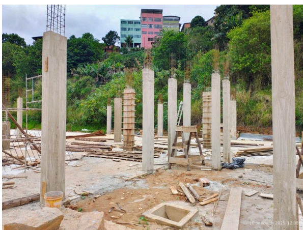
Foto 01 – Concretagem dos pilares.
