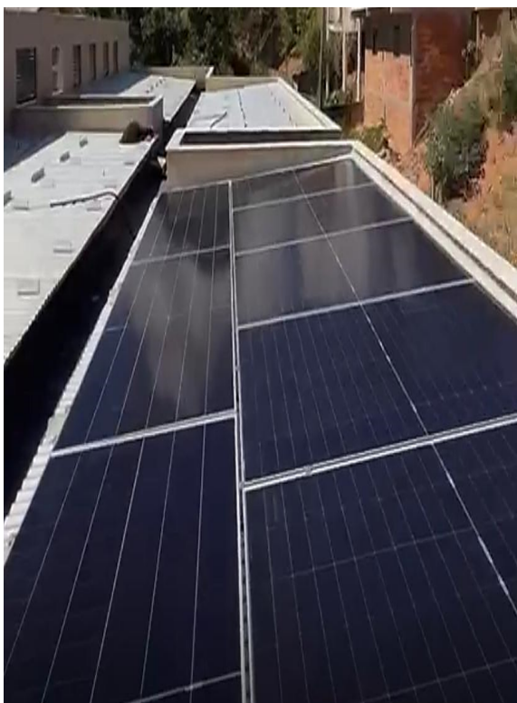
Foto 07 – Instalação do sistema de energia solar fotovoltaica
