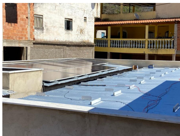
Foto 06 – Instalação do sistema de energia solar fotovoltaica
