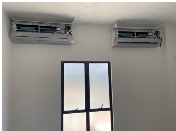
Foto 02 – Instalação de ar condicionado.
