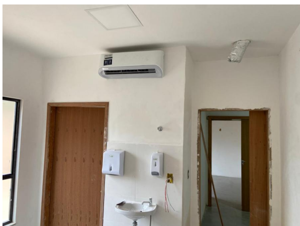
Foto 01 – Instalação de ar condicionado.
