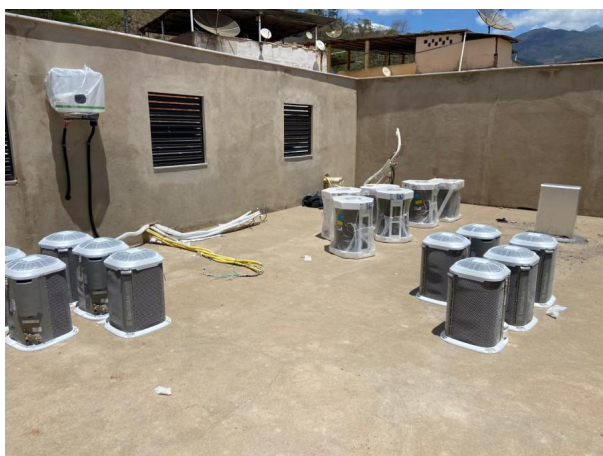
Foto 03 – Instalação das condensadoras na laje técnica
