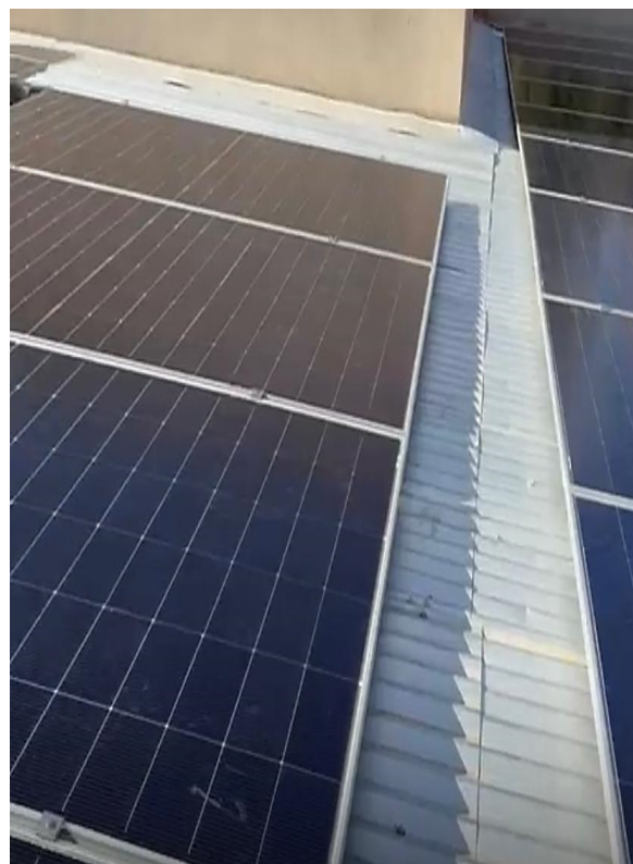
Foto 08 – Instalação do sistema de energia solar fotovoltaica
