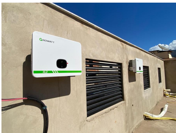
Foto 05 – Instalação do sistema de energia solar fotovoltaica
