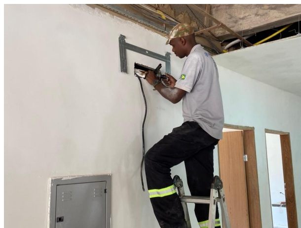
Foto 04 – Instalação de ar condicionado.
