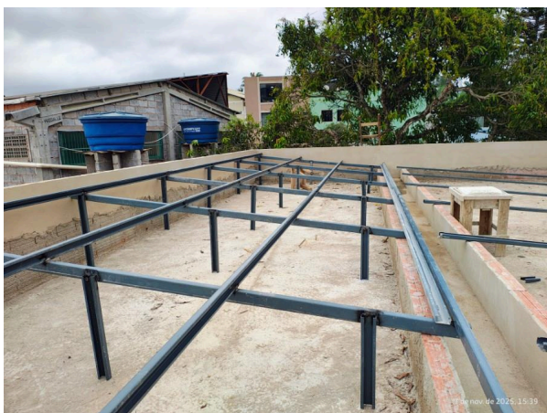
Foto 5 - Armação da estrutura para o telhado da cobertura.
