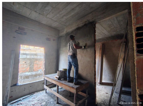
Foto 4 - Execução de reboco em alvenaria.
