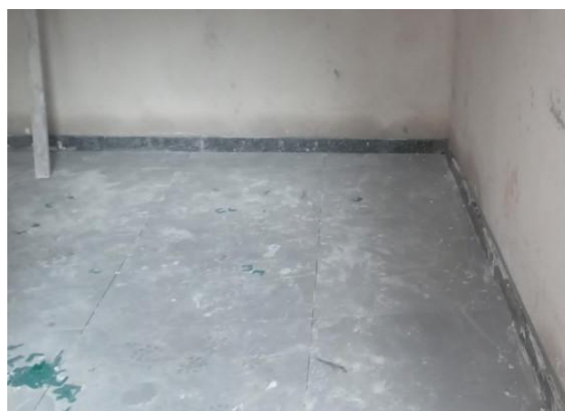
Foto 08 – Instalação de rodapé.
