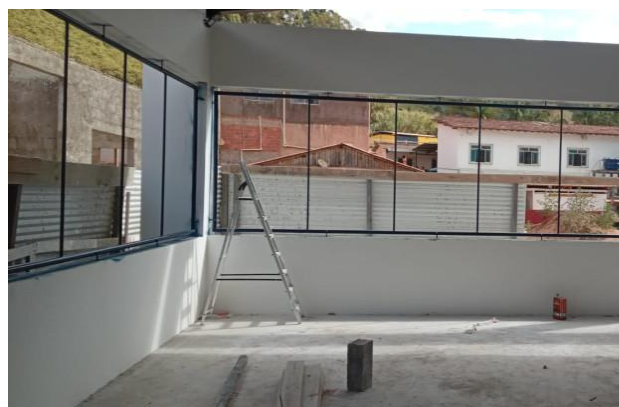
Foto 10 – Instalação de alambrado.
