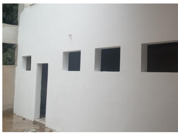
Foto 02 – Emassamento das paredes dos vestiários
