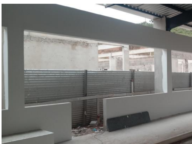
Foto 01 – Emassamento de vigas e pilares da quadra.
