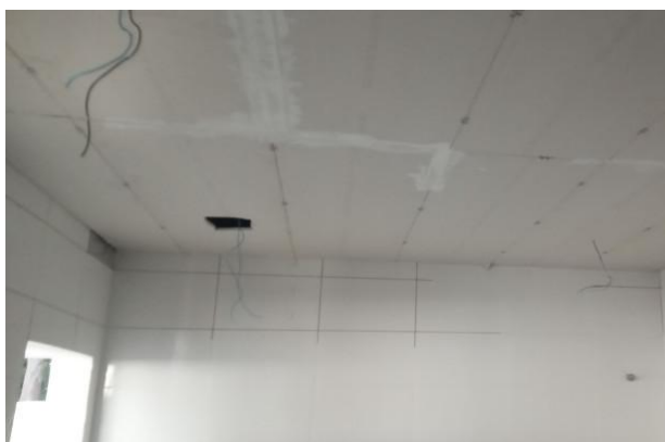
Foto 09 – Instalação de forro em gesso.
