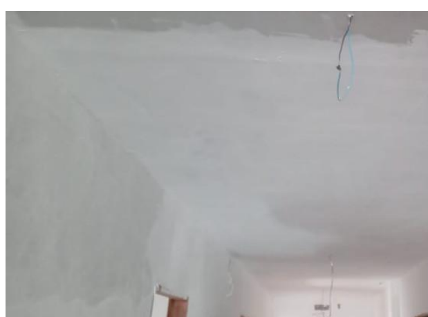
Foto 06 – Execução do forro do teto
