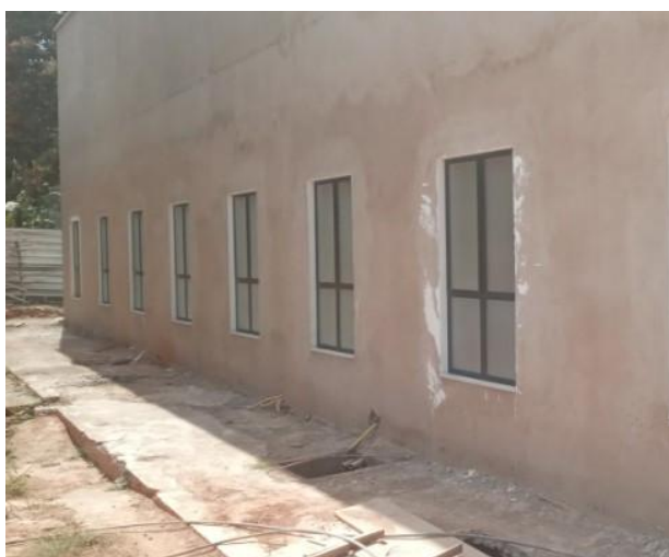
Foto 01 – Instalação das Esquadrias.
