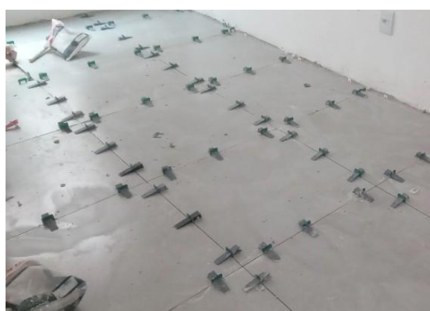
Foto 08 – Assentamento de piso.
