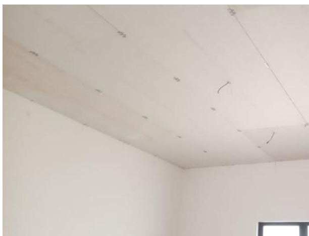
Foto 05 – Execução do forro do teto.
