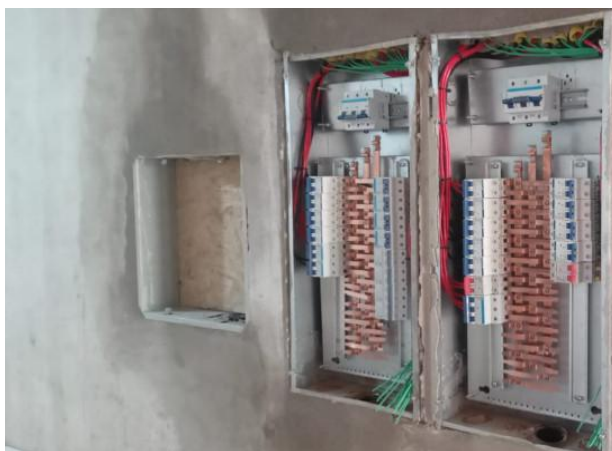
Foto 03 – Instalação dos disjuntores.
