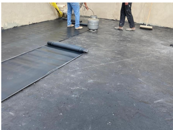
Foto 03 – Aplicação de manta asfáltica.
