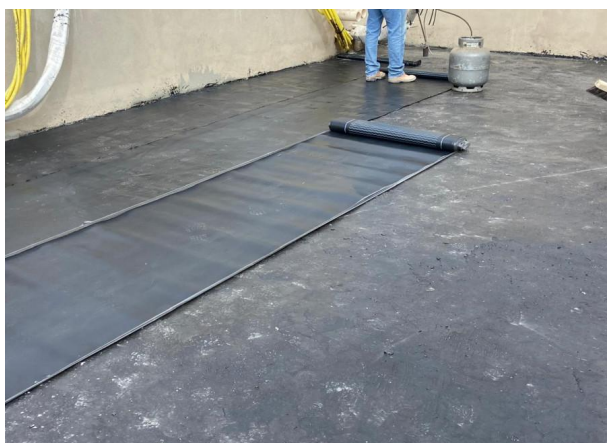
Foto 05 – Aplicação de manta asfáltica.
