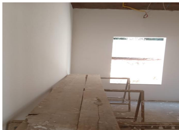
Foto 08 – Execução de emassamento das paredes.
