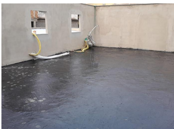
Foto 01 – Aplicação de primer asfáltico.
