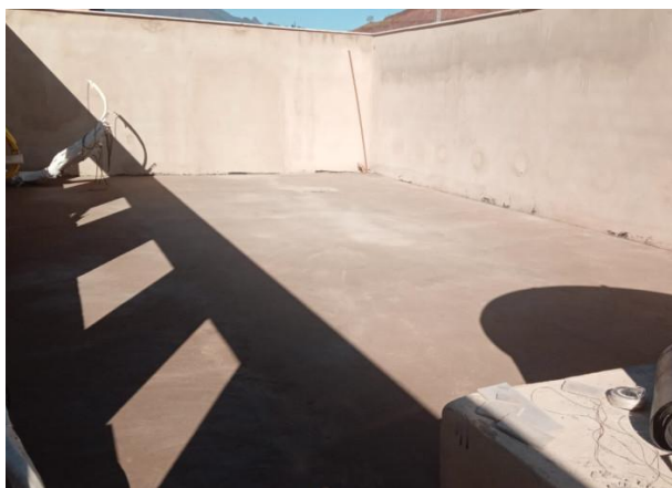
Foto 07 – Execução de contrapiso.
