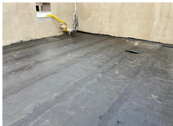
Foto 04 – Aplicação de manta asfáltica.
