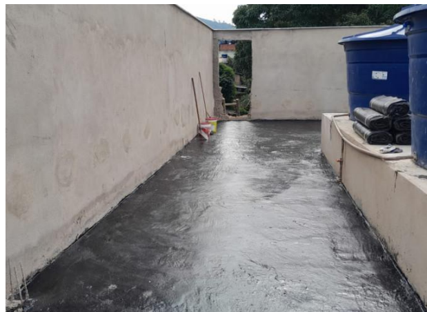
Foto 02 – Aplicação de primer asfáltico.
