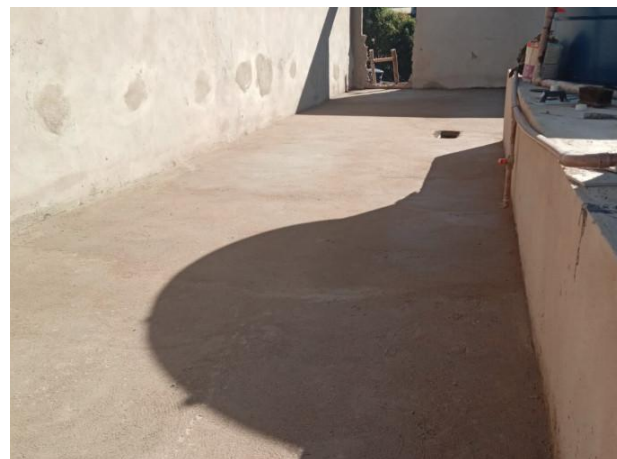
Foto 06 – Execução de contrapiso.
