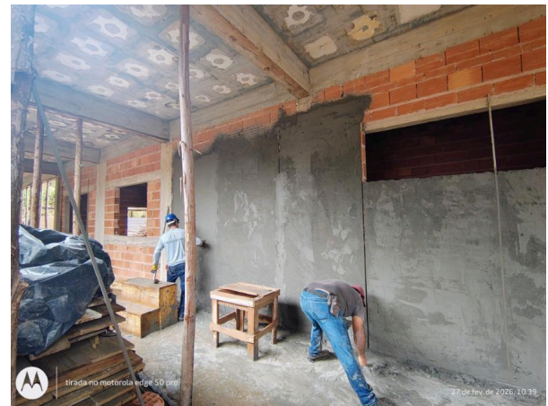
Foto 02 – Execução de reboco.
