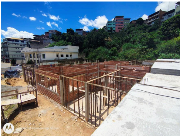
Foto 03 – Execução de alvenaria.
