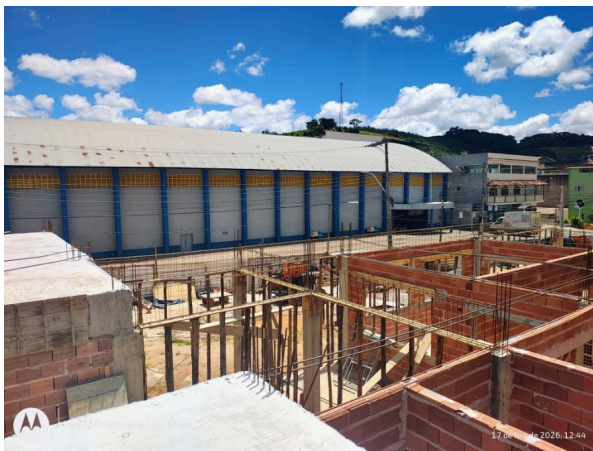
Foto 07 – Execução de armação das vigas.
