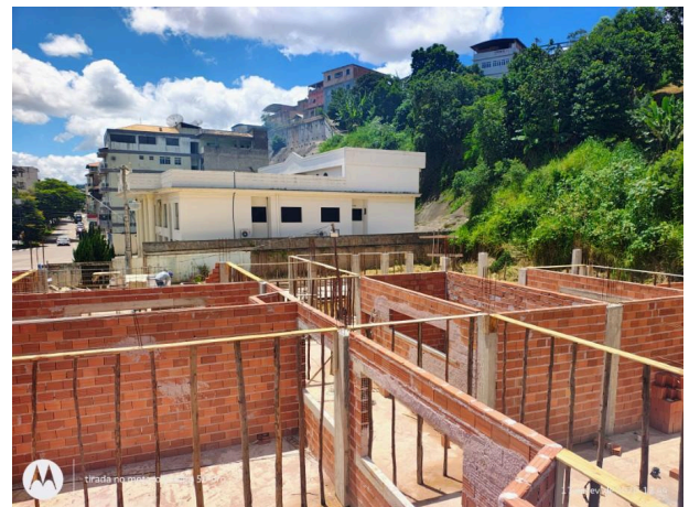
Foto 08 – Execução de armação das vigas.
