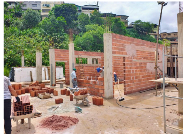
Foto 04 – Execução de alvenaria.
