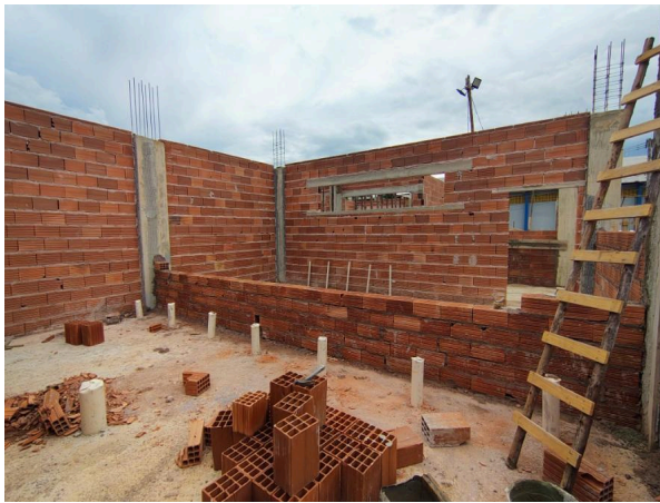
Foto 05 – Execução de alvenaria.
