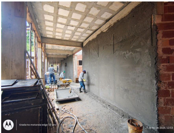
Foto 01 – Execução de reboco.
