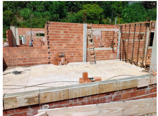
Foto 06 – Execução de alvenaria.
