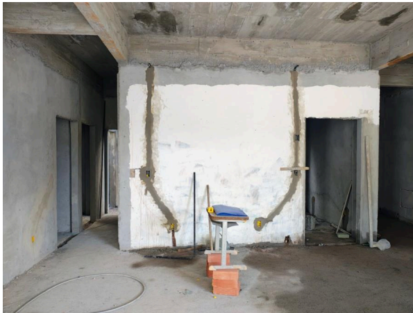
Foto 5 - Execução de instalações hidráulicas e elétricas
