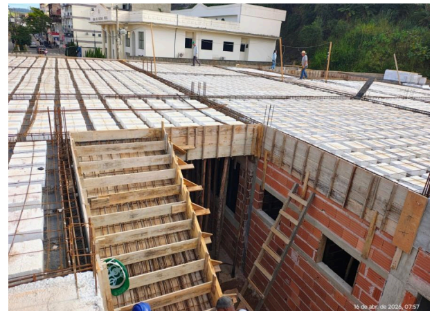
Foto 04 – Colocação de forma das lajes.
