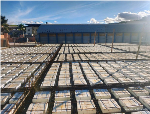
Foto 05 – Colocação de forma das lajes.
