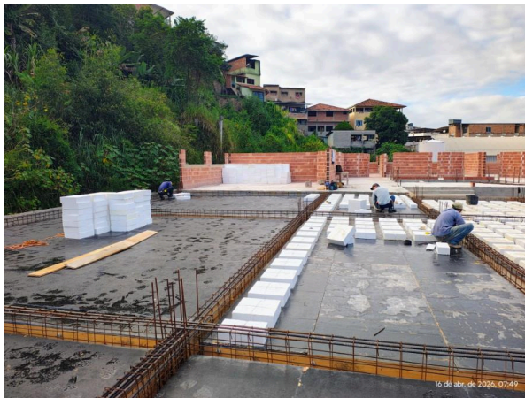
Foto 03 – Colocação de forma das lajes.
