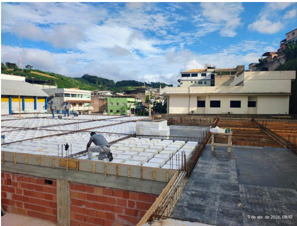
Foto 07 – Colocação de forma das lajes.
