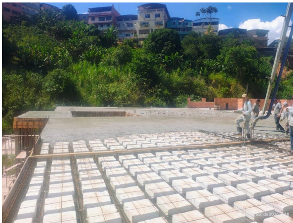
Foto 01 – Concretagem da laje.
