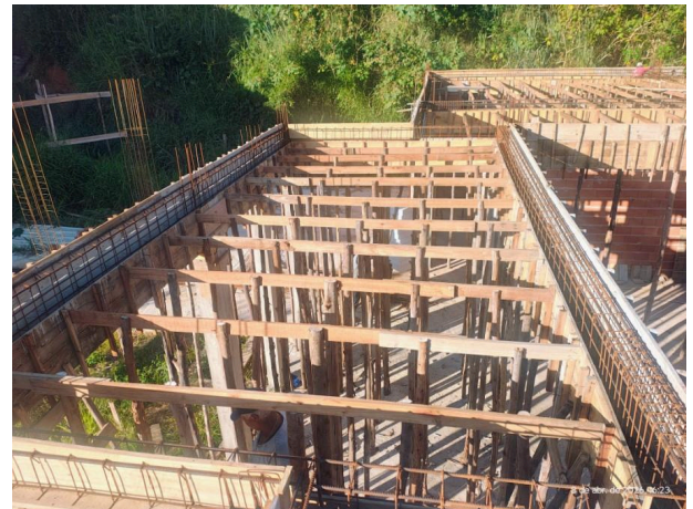
Foto 08 – Colocação de forma das lajes.
