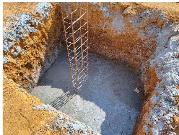
Foto 6 - Concretagem da fundação
