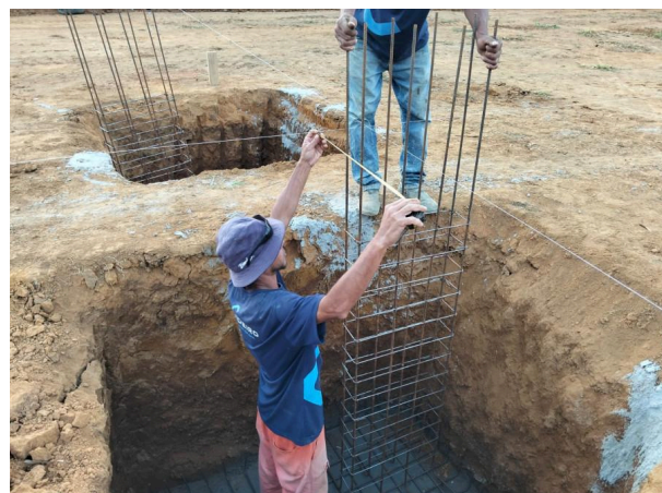
Foto 4 - Execução da fundação
