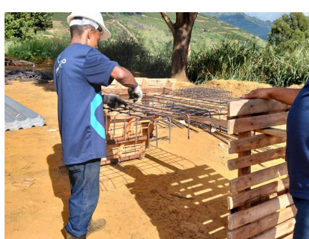
Foto 2 - Armação das ferragens da fundação
