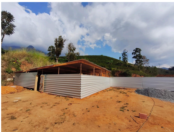
Foto 3 - Execução de tapume e barracão
