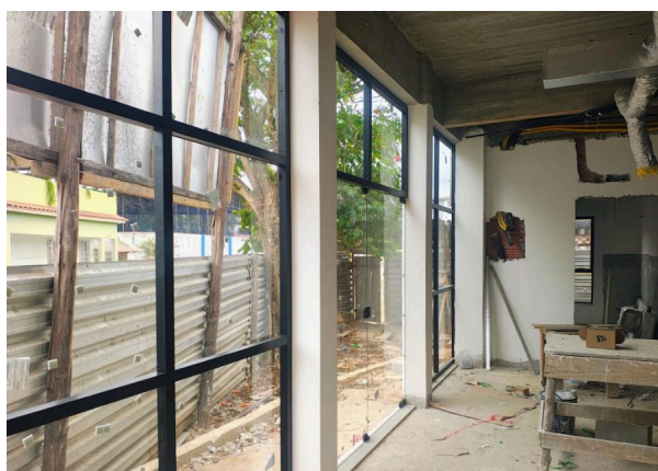
Foto 1 - Instalação de porta de vidro
