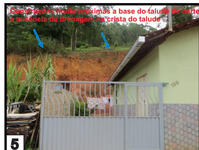
**Descrição:** Encosta com média declividade e altura aproximada de 30 metros. A base está ocupada por moradias de alvenaria. Inúmeros cortes verticais na base da encosta com as construções muito próximas a base ou topo do talude de corte.
