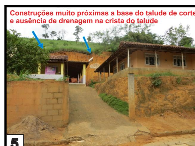
**Descrição:** Encosta com declividade média e altura elevada cuja base está ocupada por moradias de bom padrão construtivo. Inúmeros cortes verticais na base da encosta, alguns de grande altura.
