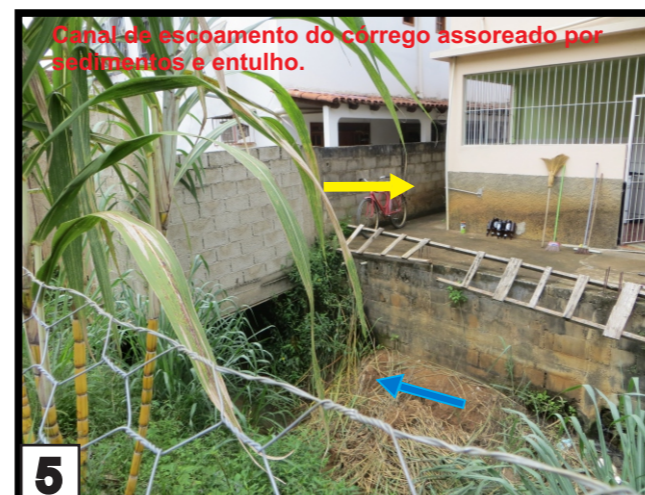
Moradias construídas, praticamente, sobre o canal do Córrego Ferrugem.
