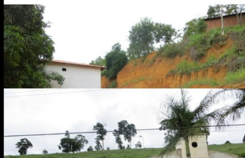
Proximidade da moradia à base do talude de corte e ausência de drenagem na crista do talude
