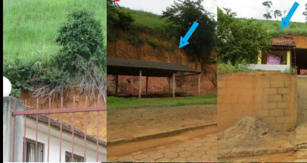
Proximidade da moradia à base do talude de corte e ausência de drenagem na crista do talude
