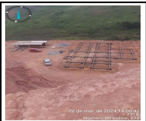
Impermeabilização da fundação
