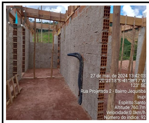
Execução chapisco interno
