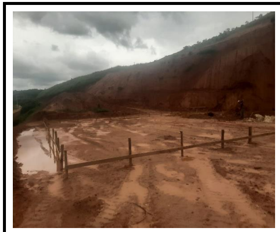
Locação de obra
