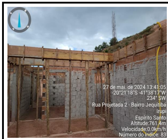
Execução de superestrutura - Vigas
