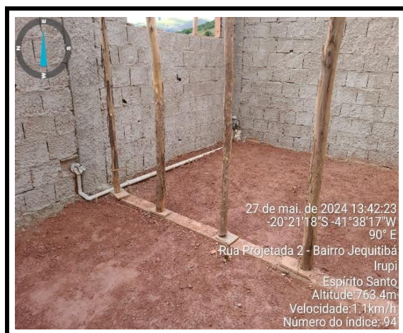
Execução pontos hidrossanitários
