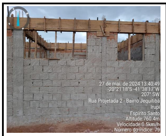
Excução de alvenaria
