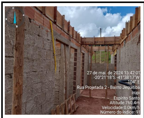
Execução chapisco interno
