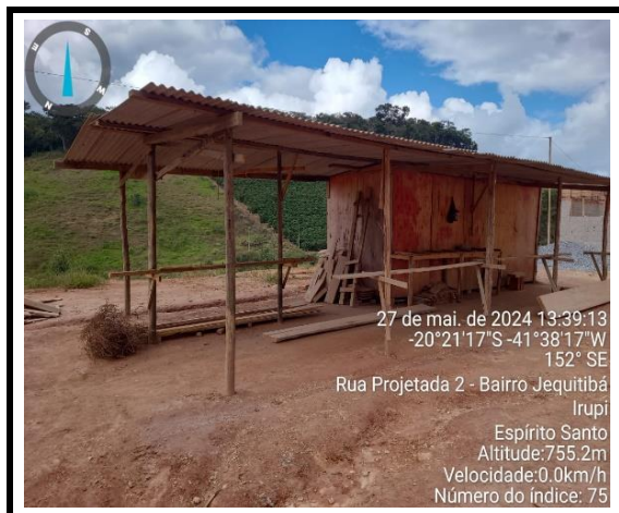
Execução de Barracão
