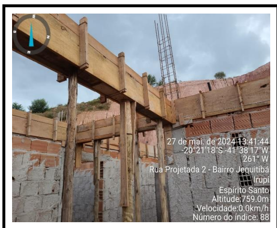
Execução de forma - superestrutura
