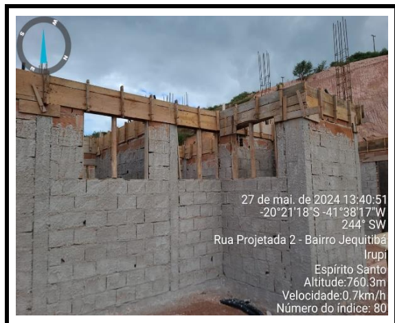
Execução superestrutura - Pilares
