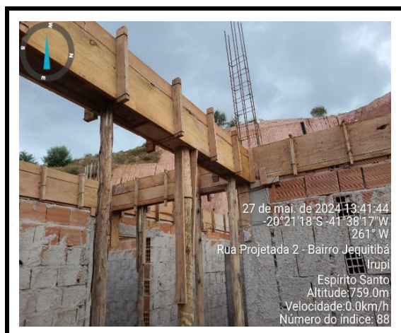
Execução de chapisco interno
