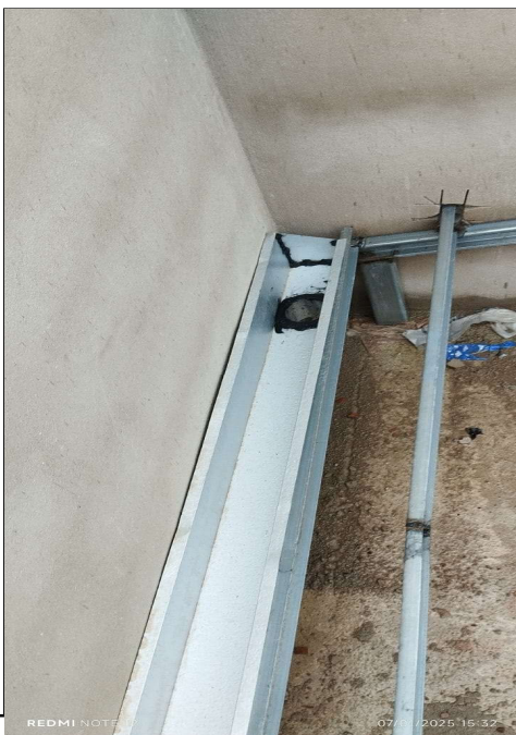
INSTALAÇÃO DE CALHA
