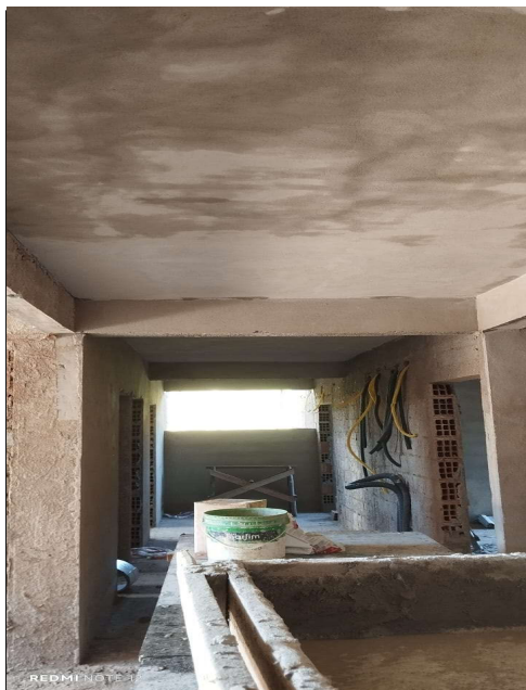
REBOCO EM TETO
