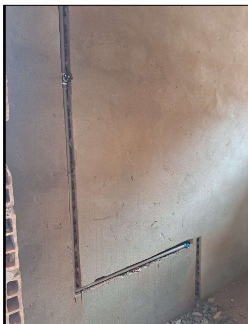
INSTALAÇÃO DE REGISTRO
