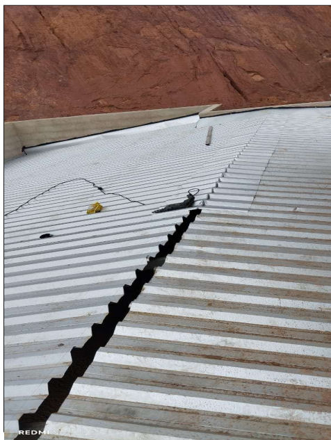
COBERTURA COM TELHAS TRAPEZOIDAIS
