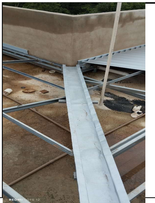
INSTALAÇÃO DE CALHA
