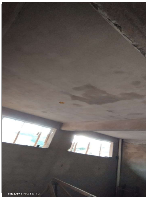
REBOCO EM TETO
