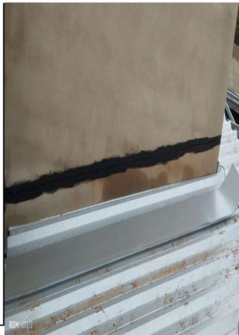
INSTALAÇÃO DE RUFO METÁLICO
