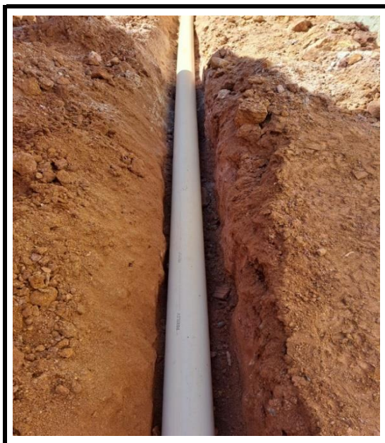
INSTALAÇÃO DE TUBULAÇÃO DE ESGOTO
