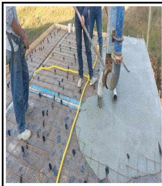
CONCRETAGEM DA LAJE
