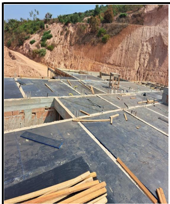
MONTAGEM DE FORMA PARA LAJE
