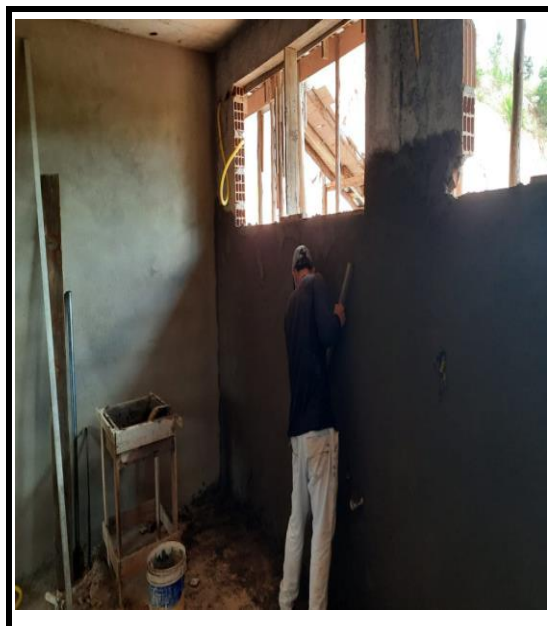
EXECUÇÃO DE EMBOÇO
