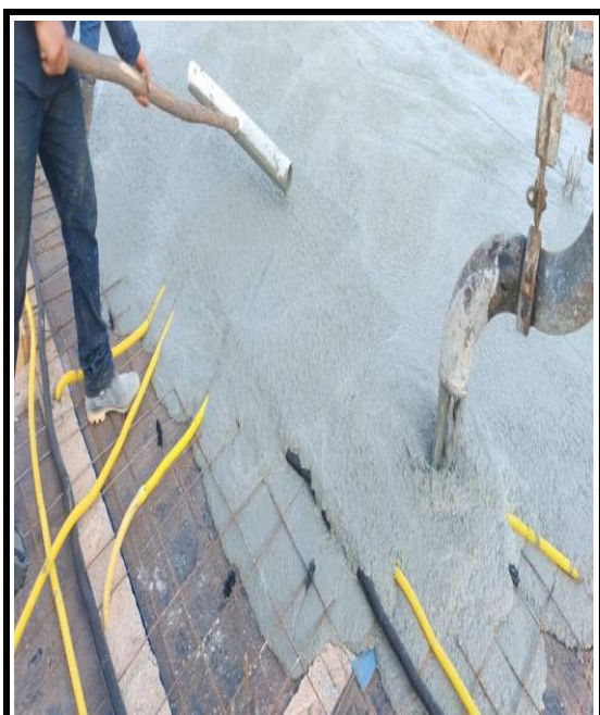
CONCRETAGEM DA LAJE
