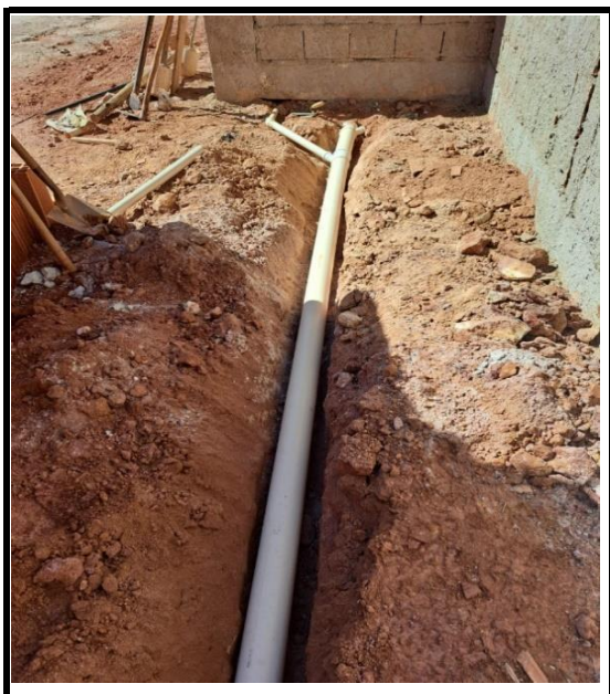
INSTALAÇÃO DE TUBULAÇÃO DE ESGOTO
