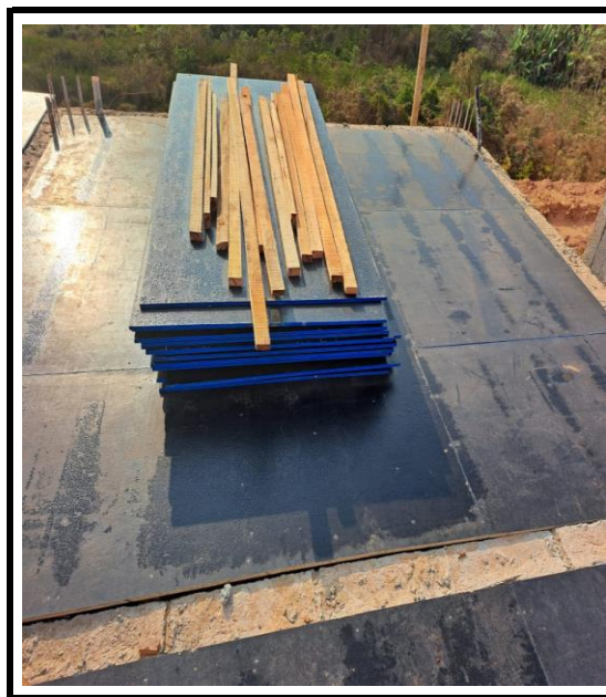
MONTAGEM DE FORMA PARA LAJE
