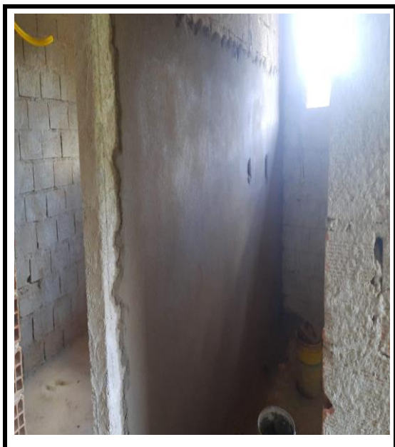
EXECUÇÃO DE EMBOÇO
