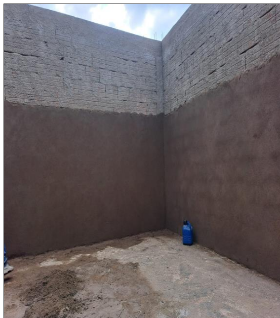
EXECUÇÃO DE EMBOÇO NA ÁREA DA COBERTURA
