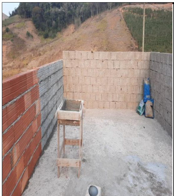
EXECUÇÃO DE CHAPISCO NA ÁREA DA COBERTURA
