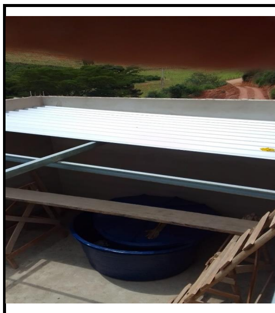
EXECUÇÃO DE COBERTURA
