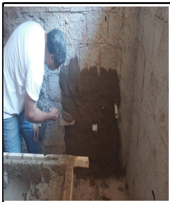
EXECUÇÃO DE EMBOÇO
