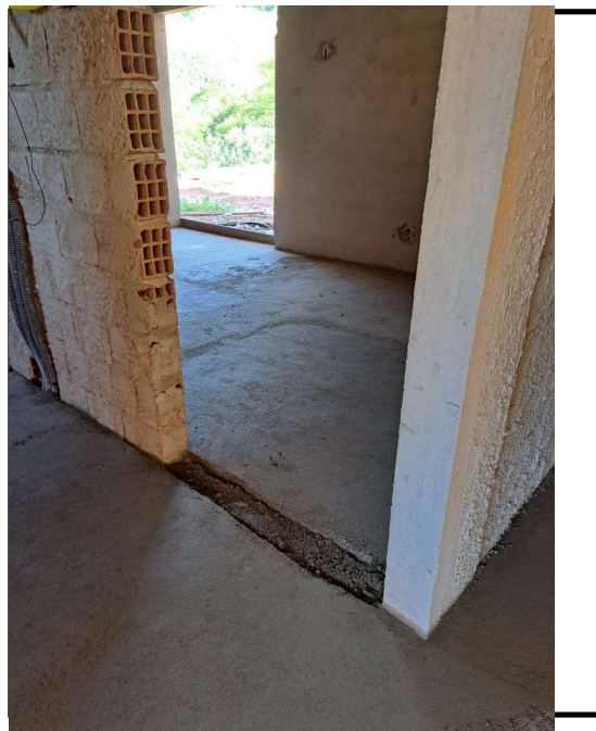
EXECUÇÃO DE CONTRAPISO
