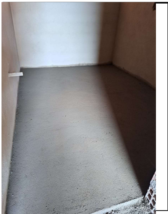
EXECUÇÃO DE CONTRAPISO
