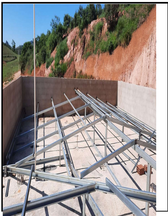
EXECUÇÃO DE TRAMA METÁLICA PARA COBERTURA
