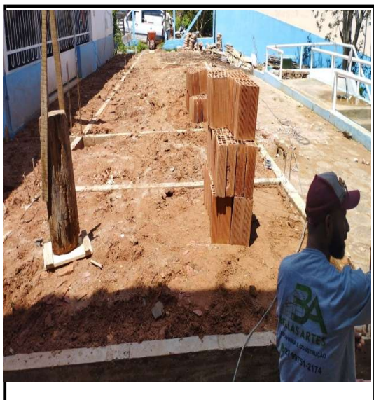
Figura 9 - Fôrma, armadura e concreto (viga Baldrame) E Aterro de base - Cozinha
