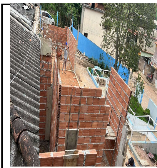
Figura 11 - Fôrma, Armadura e concreto (pilar) e Alvenaria - Cozinha
