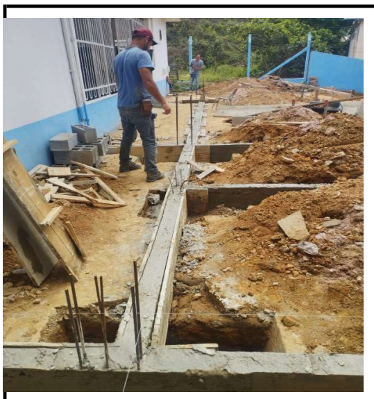
Figura 7 - Fôrma, armadura e concreto (viga Baldrame) - Cozinha
