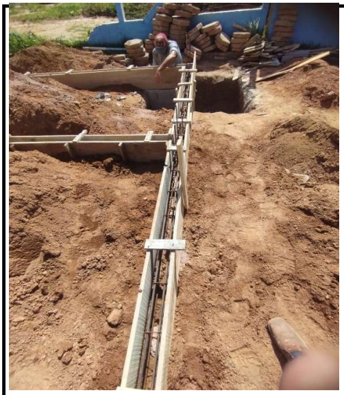
Figura 6 - Escavação - Forma e Armadura - Cozinha
