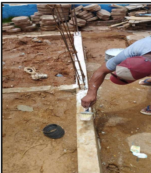
Figura 8 - Impermeabilização de infraestrutura - Cozinha.
