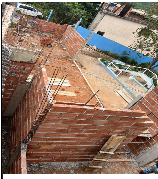
Figura 12 - Fôrma, Armadura e concreto (pilar) e Alvenaria - Cozinha
