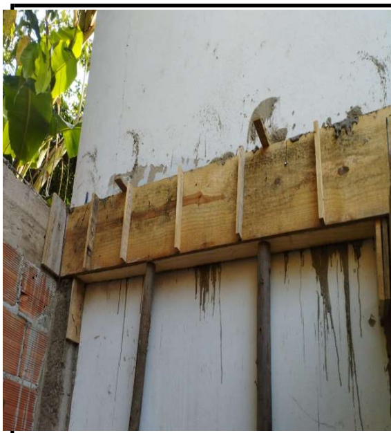
Figura 2 - Execução de Forma, Armadura e Concreto de Vigas - Palco
