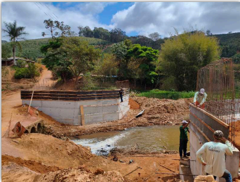
montagem de forma
