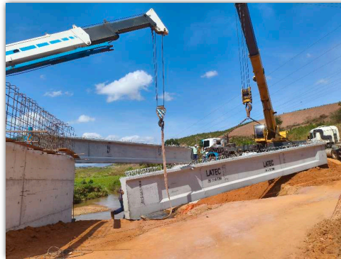
içamento das vigas
