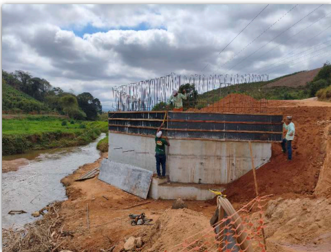
montagem de forma
