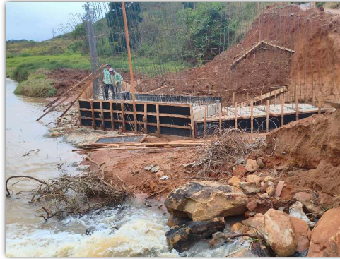
retirada de forma e armação de ferragem
