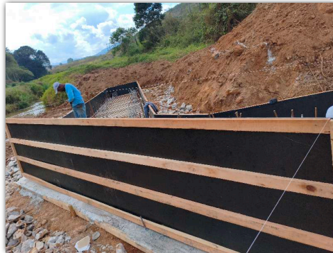
montagem de forma
