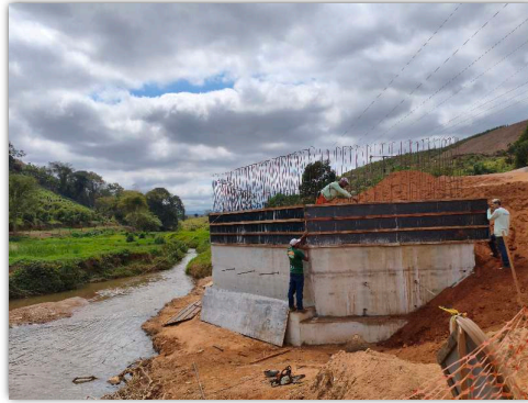
montagem de forma
