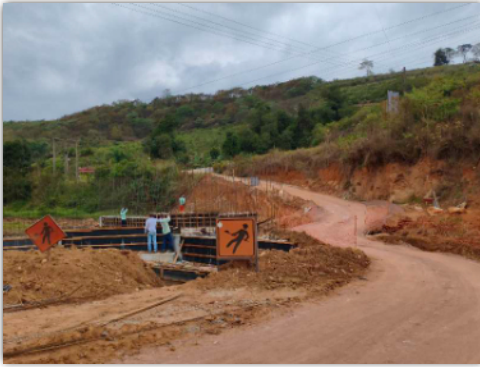
sinalização de obra e segurança
