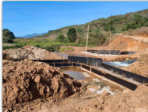
fundação e nivelamento
