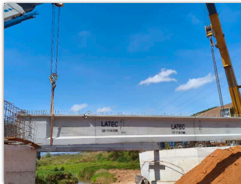
içamento de vigas
