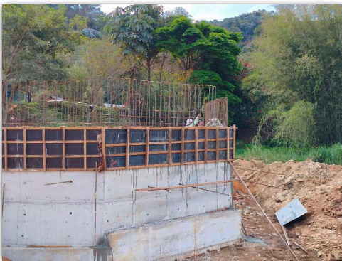
montagem de forma
