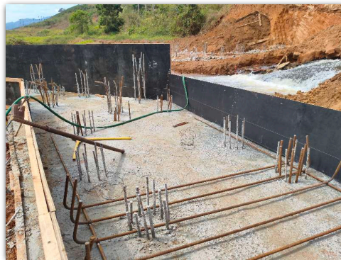
forma e armação de ferragem
