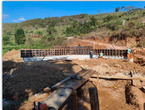
Montagem de forma
