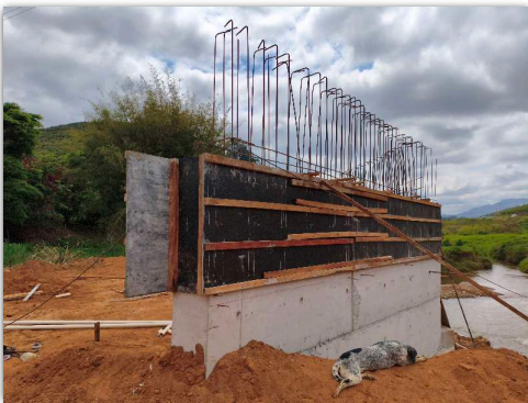
montagem de forma
