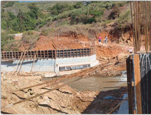
montagem de forma
