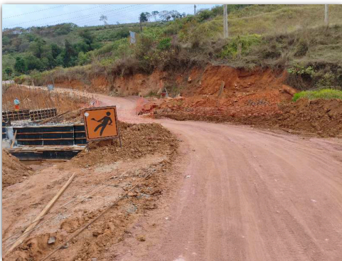
sinalização de obra
