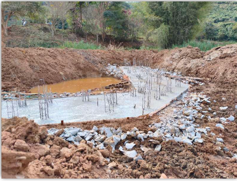
concretagem fundação
