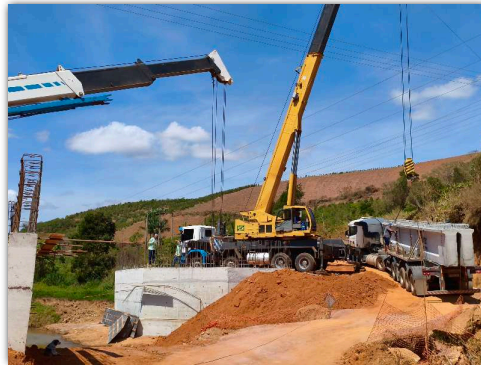
equipamentos para içamentos de vigas
