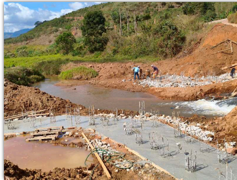
concretagem fundação
