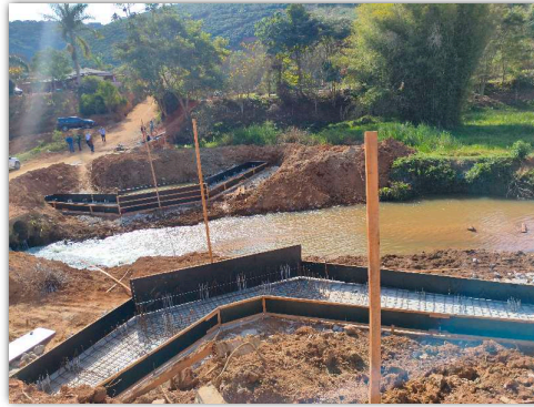
nivelamento, forma e armação de ferragem
