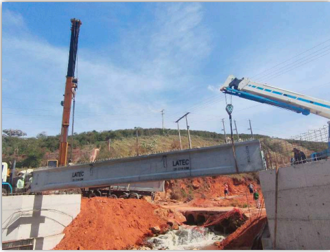
içamento de vigas
