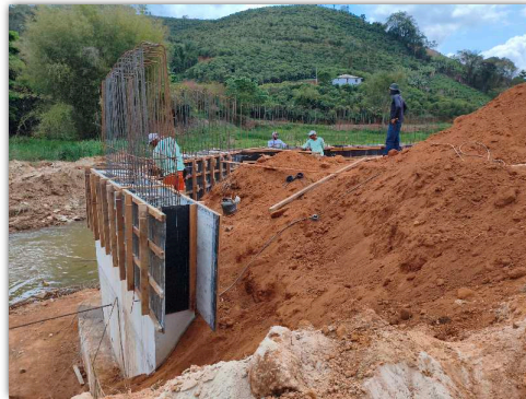
montagem de forma
