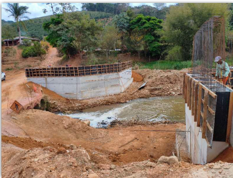
montagem de forma
