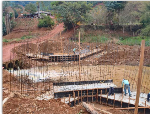
armação de ferragem e desmonte de forma
