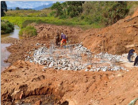
execução de fundação
