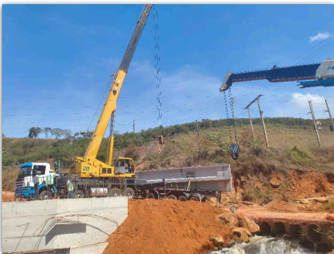
equipamentos para içamento das vigas
