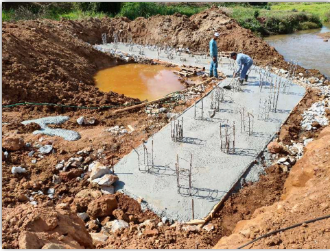
concretagem da fundação
