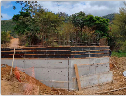
montagem de forma
