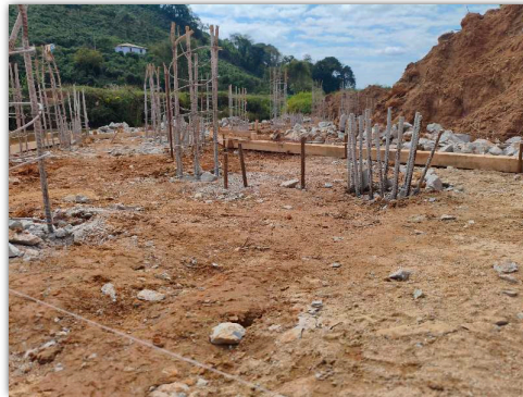
nivelamento para fundacao
