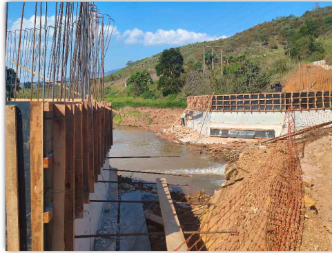
montagem de forma
