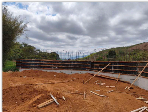
montagem de forma
