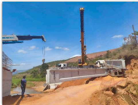
içamento das vigas
