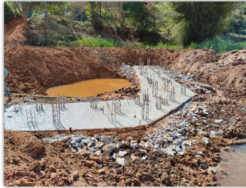
concretagem fundação
