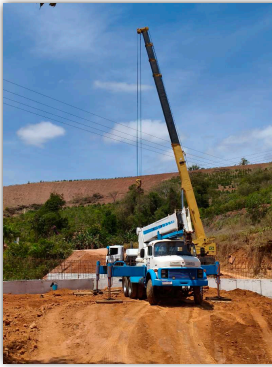
equipamentos para içamento sas vigas
