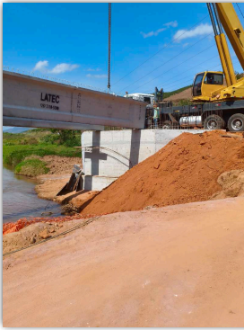
içamento das vigas
