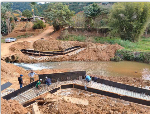
armação de ferragens e forma
