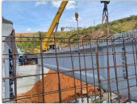
içamento das vigas
