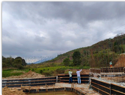
retirada de forma e armação de ferragem
