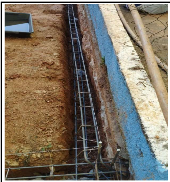
Figura 9 - Escavação e Armadura da rampa
