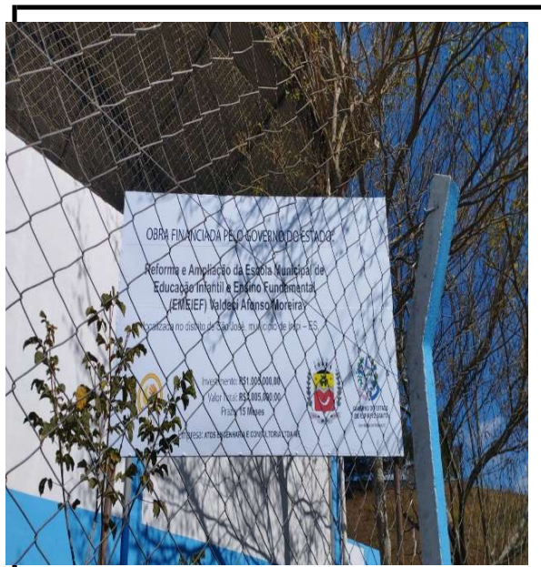
Figura 1 - Instalação de Placa de Obra
