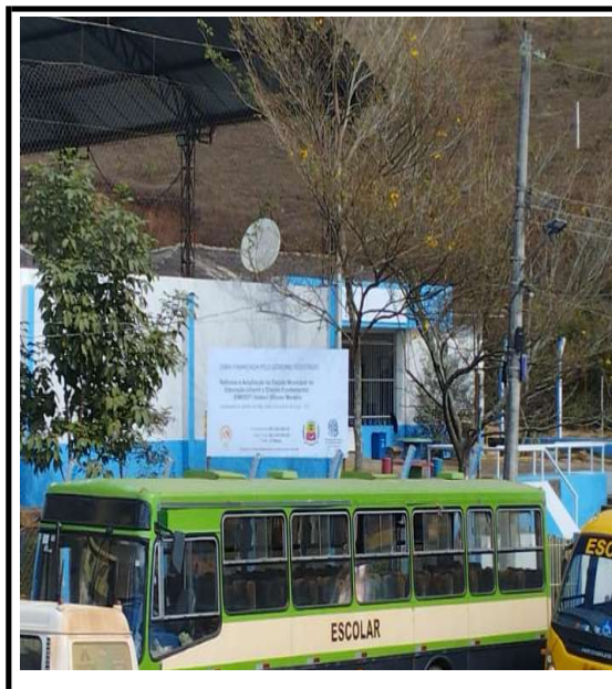
Figura 2 - Instalação de Placa de Obra.
