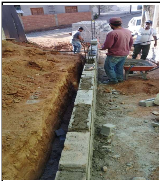
Figura 10 - Alvenaria de Blocos; Armadura e Concreto da rampa.
