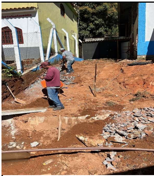
Figura 6 - Escavação da rampa e const. Barracão
