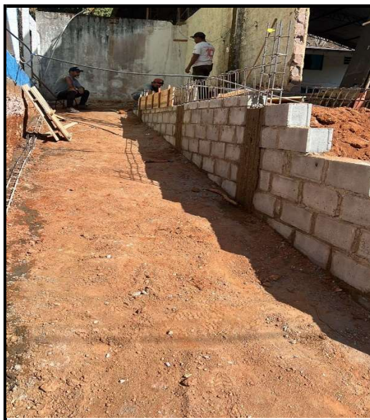
Figura 12 - Alvenaria de Blocos; Armadura e Concreto da rampa.
