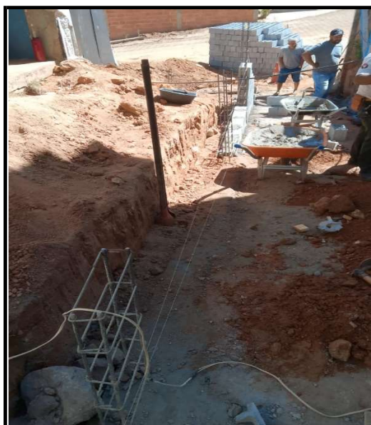
Figura 8 - fornecimento e colocação de armadura
