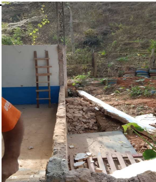
Figura 5 - Demolição de Alvenaria
