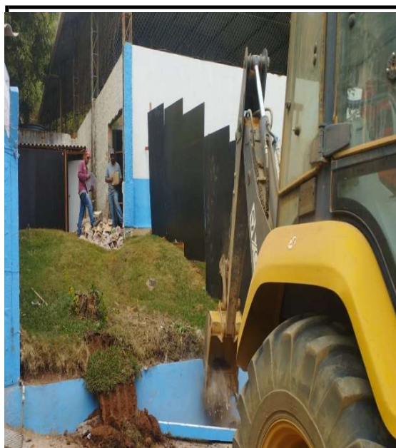
Figura 4 - Instalação de Tapume
