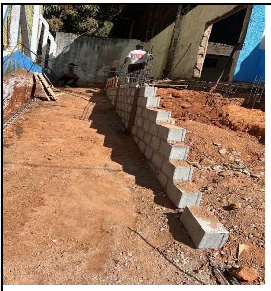
Figura 11- Alvenaria de Blocos; Armadura e Concreto da rampa.
