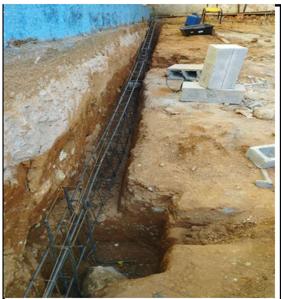
Figura 7 - Escavação e armadura de fundação rampa
