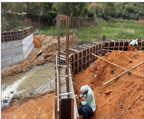
Armação da ferragem do encontro e alas
