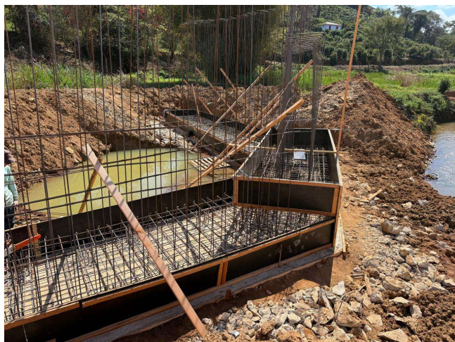
Armação da ferragem do bloco, encontro e alas
