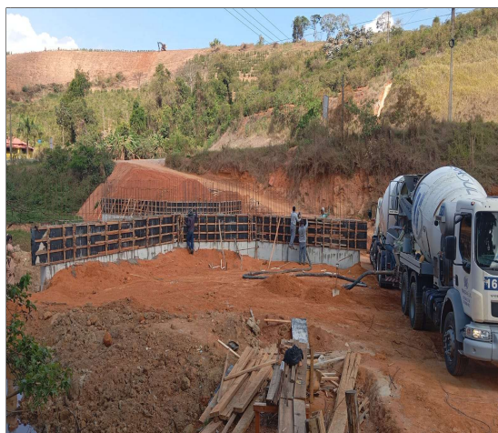
Concretagem do encontro e alas
