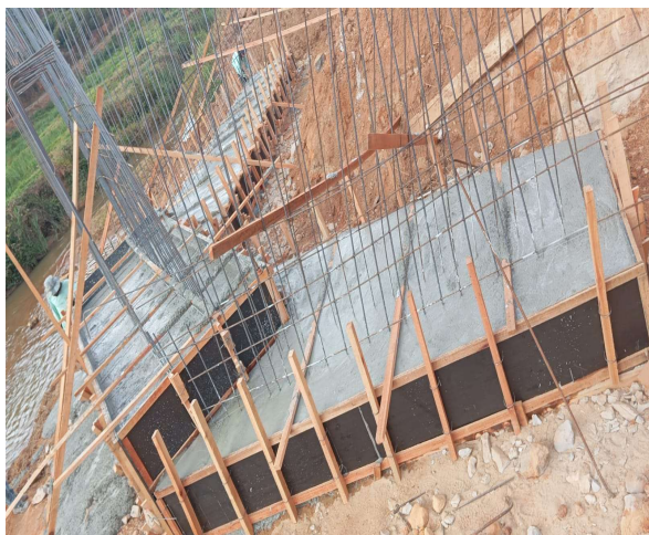
Concretagem do bloco
