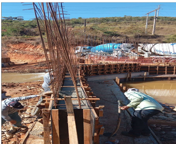
Concretagem do encontro e alas
