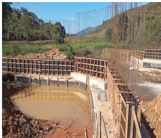
Armação da ferragem do encontro e alas
