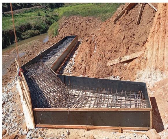
Armação da ferragem do bloco
