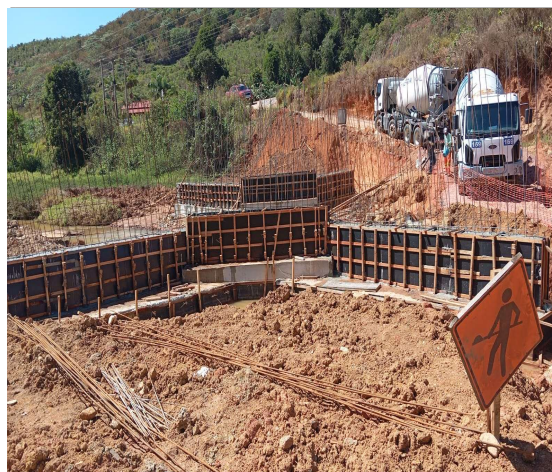
Concretagem do encontro e alas
