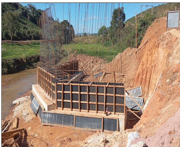
Armação da ferragem do encontro e alas
