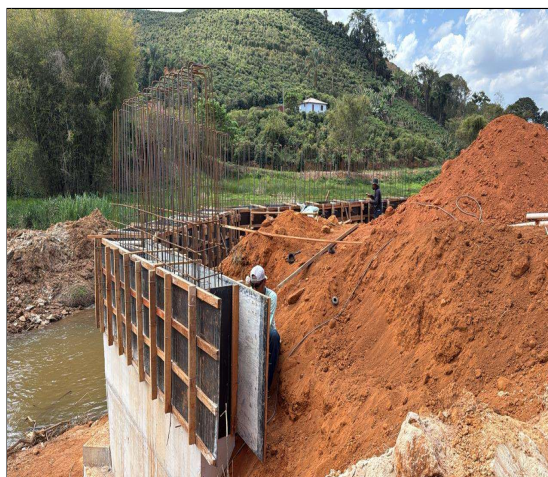
Armação da ferragem do encontro e alas
