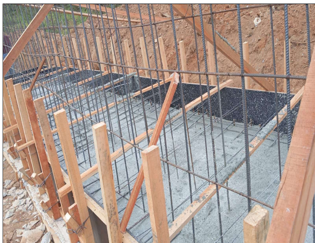
Concretagem do bloco
