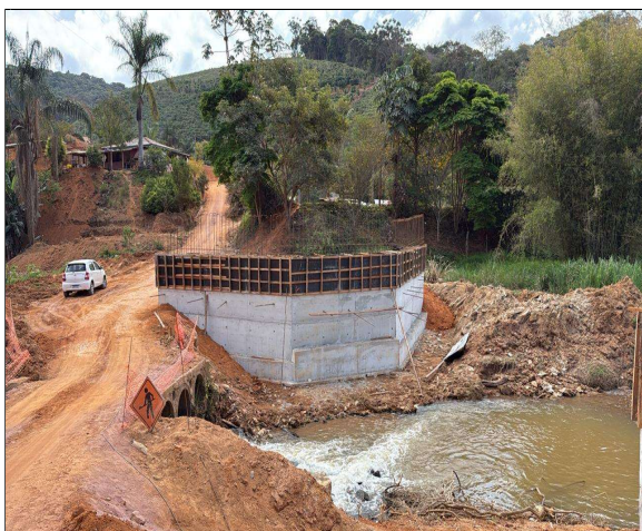
Armação da ferragem do encontro e alas
