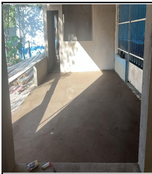
Figura 6 -reboco e Regularização de base-Cozinha
