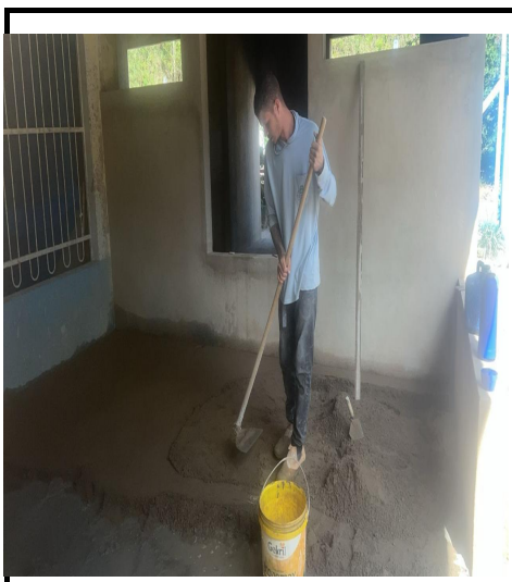
Figura 20 - Regularização de Base
