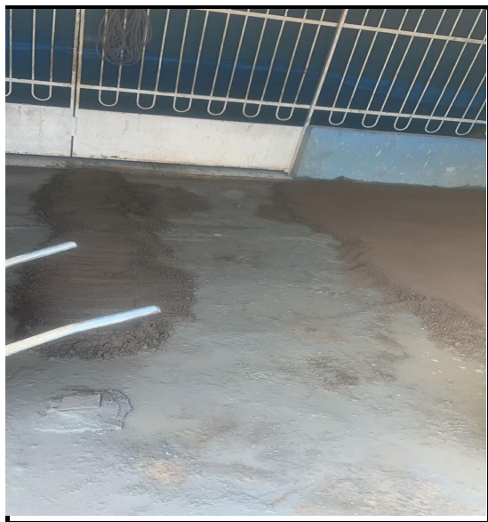
Figura 5 - Lastro e Regularização de base-cozinha
