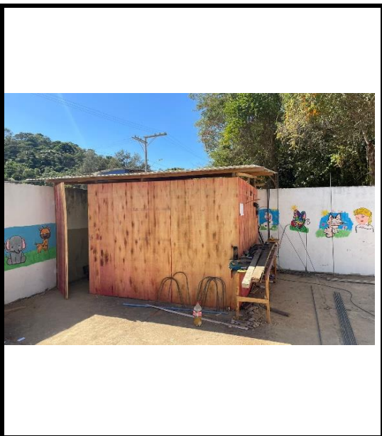
Barracão de obra
