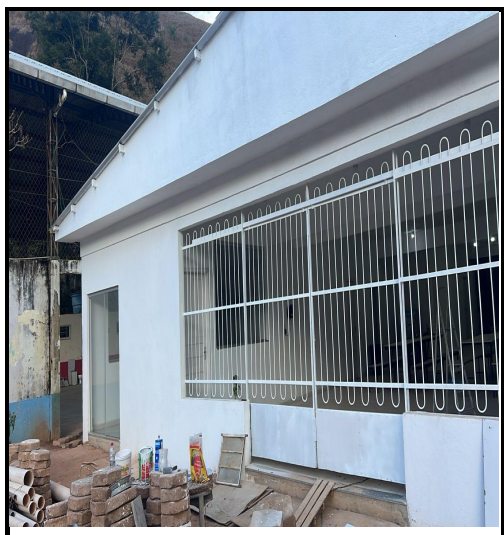
Figura 23 - Pintura de esquadria e parede externa
