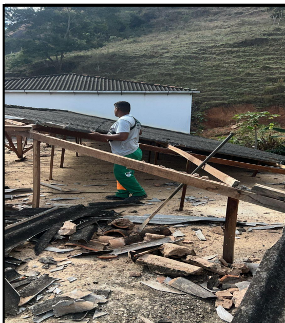
Figura 2 - Demolição de estrutura e Telhado
