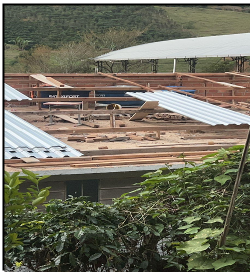
Figura 15 - Execução de estrutura de telhado
