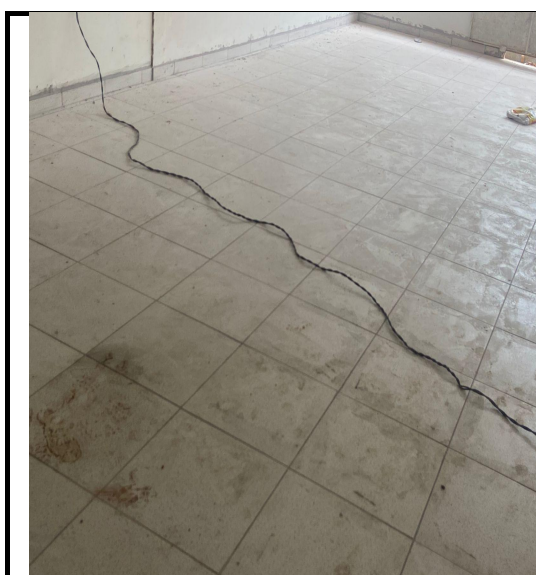
Figura 11 - Execução de piso PEI5
