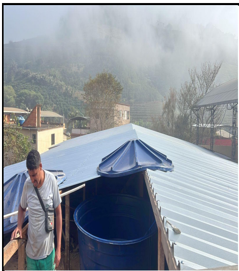
Figura 18 - Execução de telha de zinco e caixa d'água
