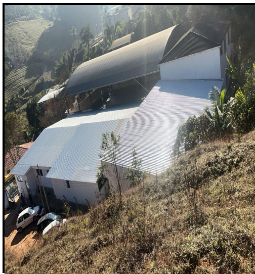
Figura 17 - Execução de telha de alumínio
