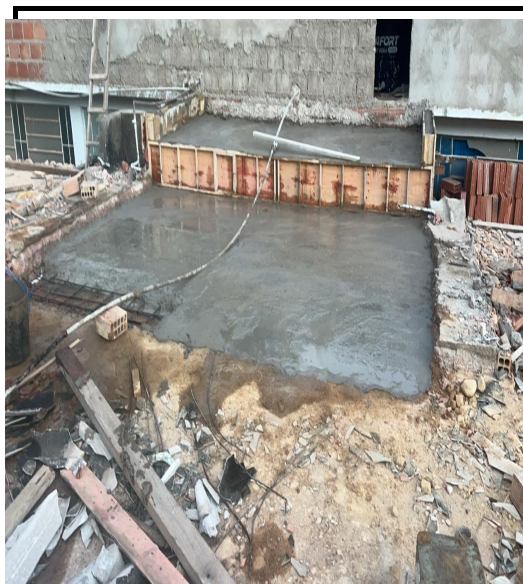
Figura 6 - Execução de forma e concreto
