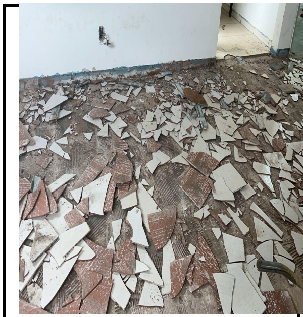
Figura 1 -Demolição de Piso
