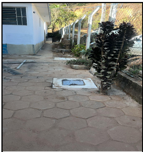
Figura 19 - Execução de caixa de inspeção
