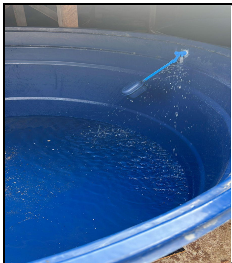
Figura 22 - Instalação de boia e conexões de instalação
