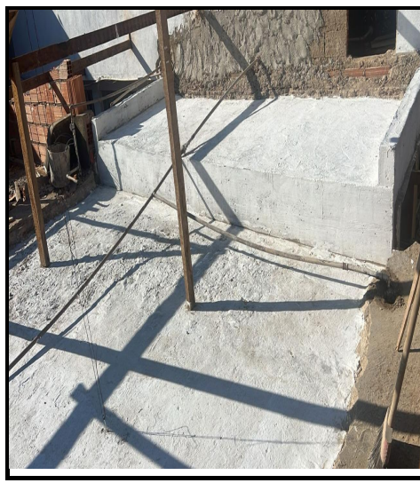
Figura 16 -execução de estrutura de telhado, concreto, instalações hidrossanitárias, conexoes e registros
