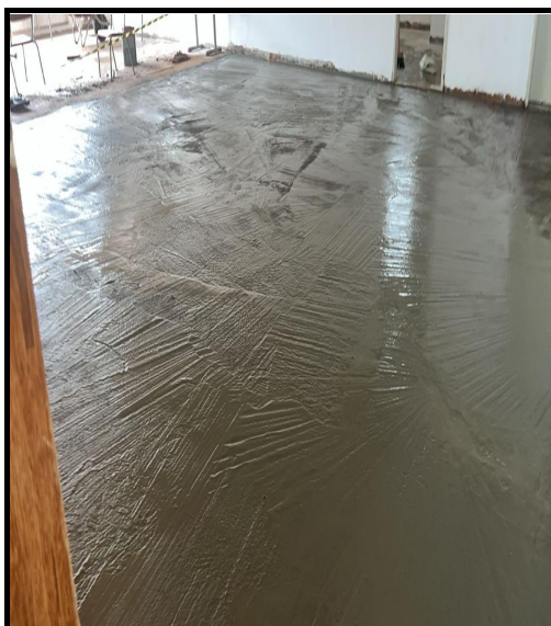
Figura 10 - Regularização de piso
