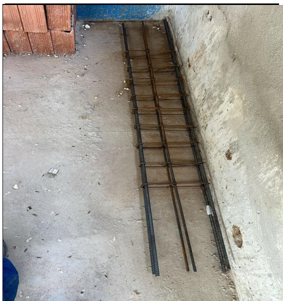
Figura 4 - Armação de ferragem
