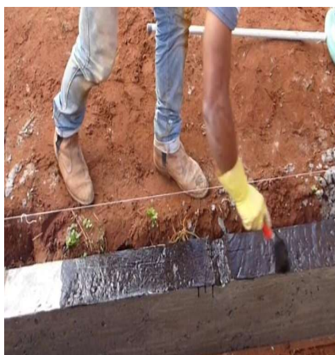
Figura 8 - Impermeabilização de infraestrutura.
