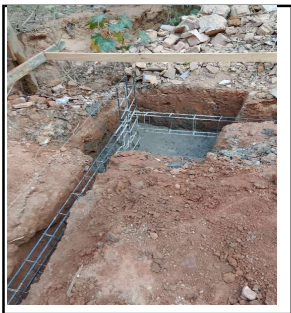
Figura 3 - Escavação - Armadura e Concreto.
