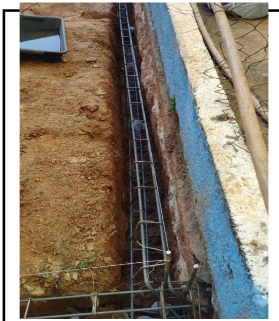
Figura 2 - Execução de Escavação- Armadura infraestrutura
