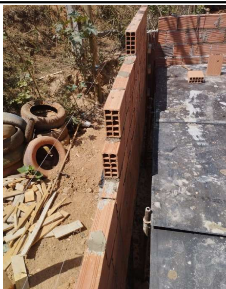
Figura 7 - Alvenaria de blocos do Palco.
