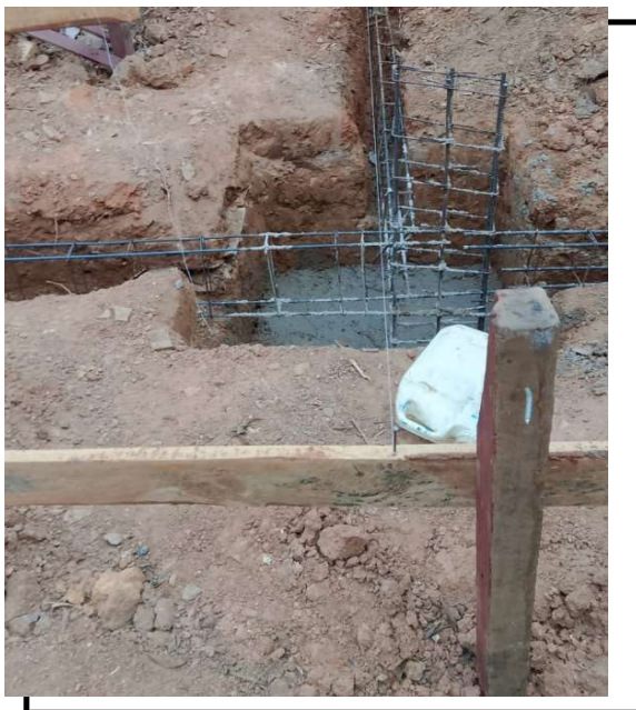
Figura 4 - Escavação - Armadura e Concreto.
