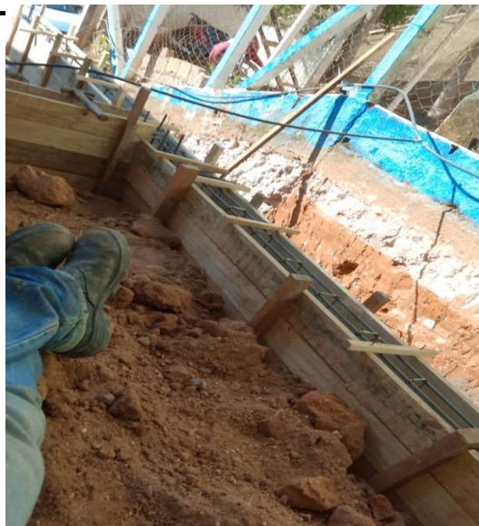
Figura 5 - Armação de Fôrma e Armadura
