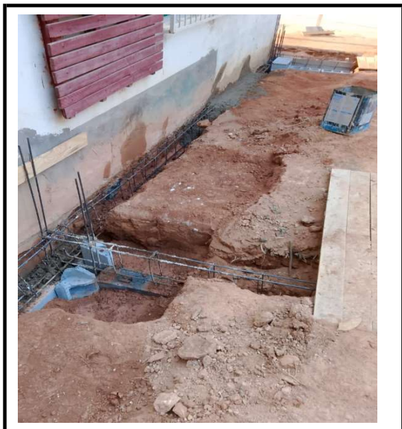
Figura 1 - Execução de Escavação- Armadura infraestrutura
