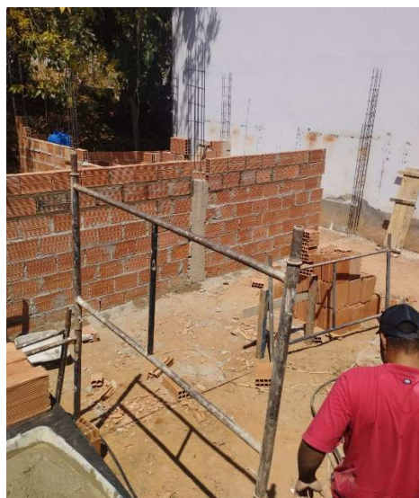
Figura 6 - Alvenaria de blocos e concretagem de pilares.
