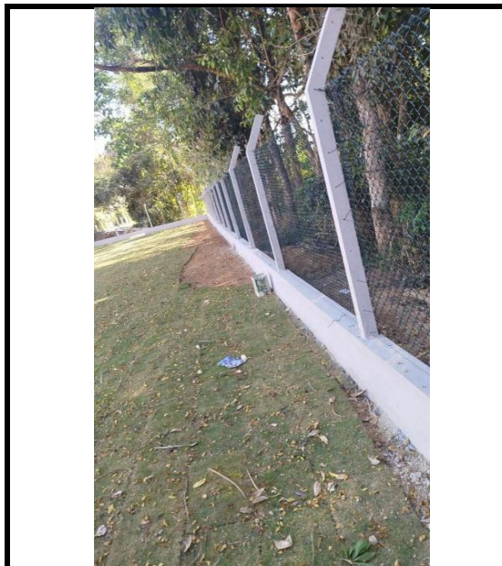
Figura 58- fixação dos alambrados na cerca e pintura da mureta
