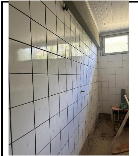
Figura 2 - Assentamento de pastilhas e rejuntamento
