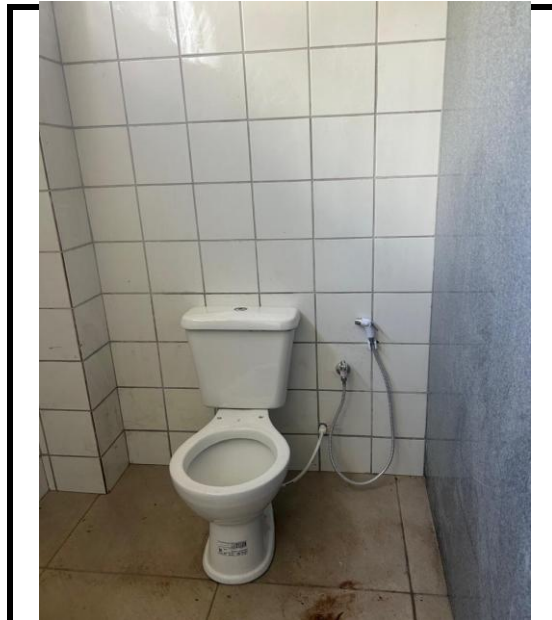
Figura 34- instalação de bacias sanitárias e ducha higiênica
