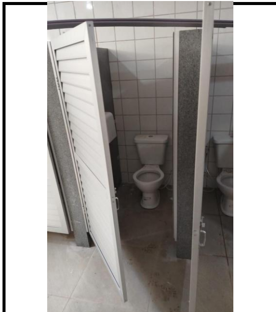
Figura 38 -instalação de portas venezianas em banheiros
