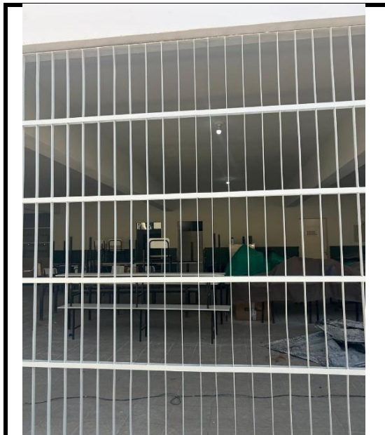
Figura 18 -Execução de pintura de grades de ferro em barra chata
