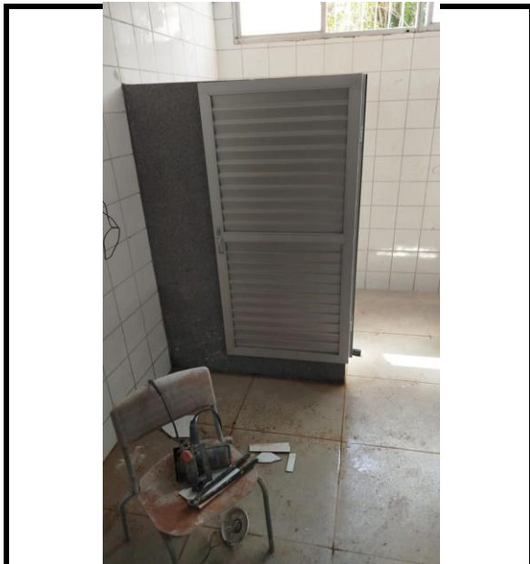
Figura 37- instalação de portas venezianas em banheiros
