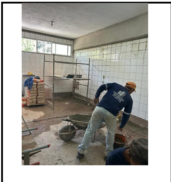
Figura 3 - Assentamento de pastilhas e rejuntamento
