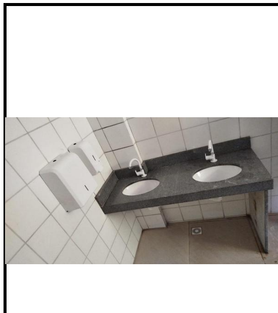
Figura 36 -assntamento de bancadas em granito em banheiros
