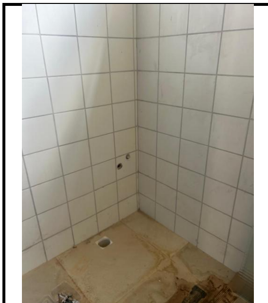
Figura 4 - Assentamento de pastilhas e rejuntamento.
