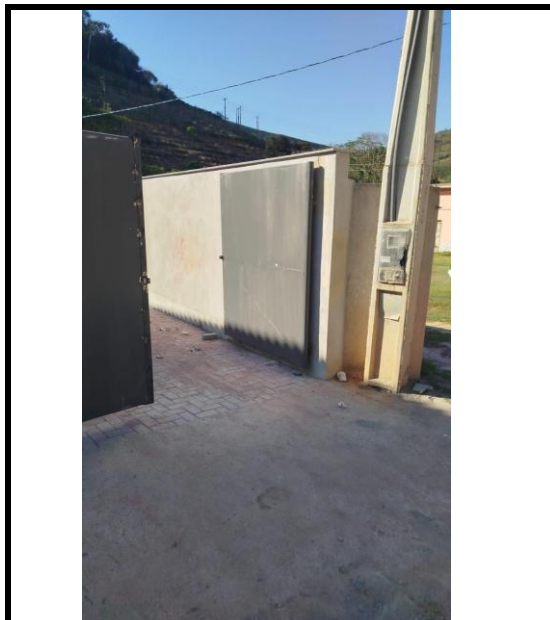
Figura 42 -iexecução de portões com chapa de aço
