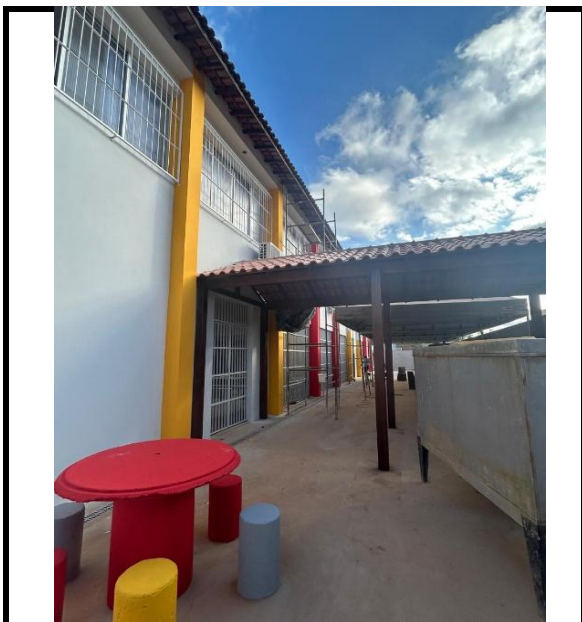
Figura 23 -Execução de madeiramento e de cobertura em telhas coloniais
