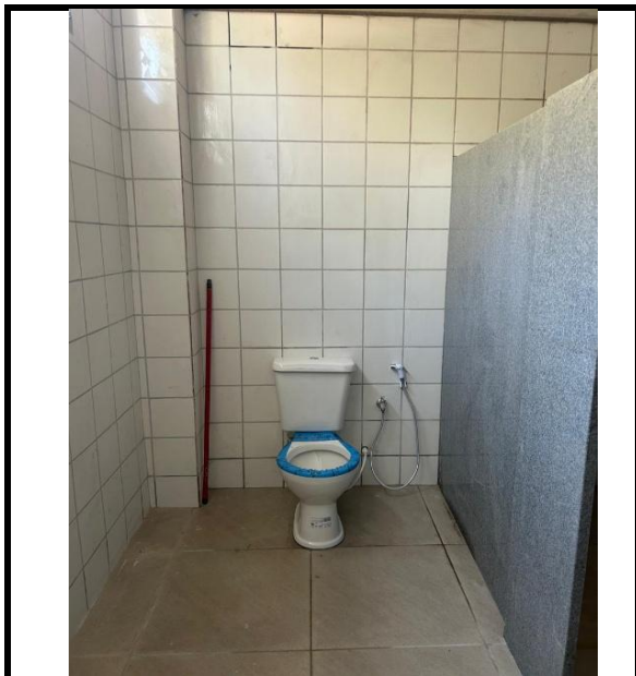
Figura 33- instalação de bacias sanitárias e ducha higiênica
