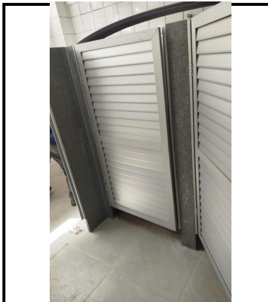
Figura 40 - instalação de portas venezianas em banheiros
