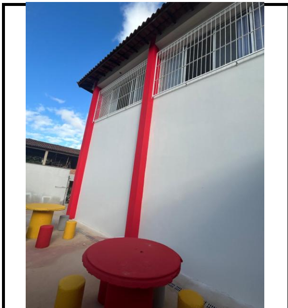
Figura 7 -Execução de pintura-exterior
