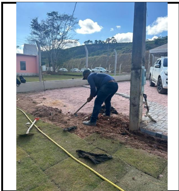
Figura 55 - execução de calçamento com bloco holandes
