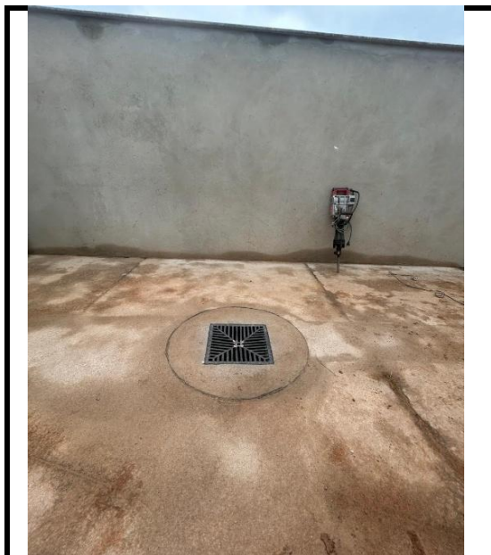
Figura 28 -chumbamento das caixas ralo de drenagem
