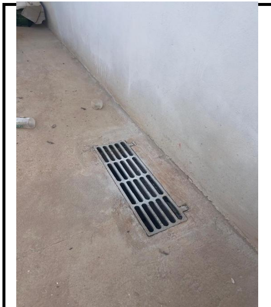
Figura 32 - execução de canal autolimpanete com grelha
