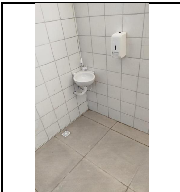
Figura 35 - instalação de cuba de canto wc pne
