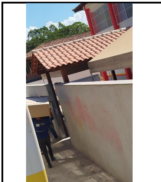
Figura 24 -Execução de madeiramento e de cobertura em telhas coloniais
