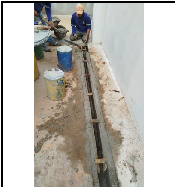
Figura 29- execução de canal autolimpanete com grelha
