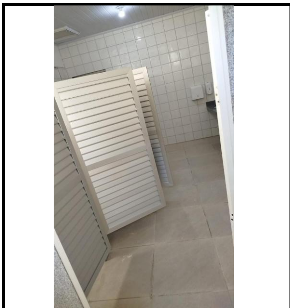
Figura 39 - instalação de portas venezianas em banheiros
