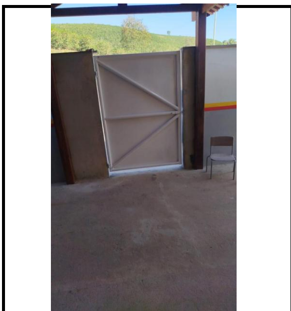
Figura 43 - execução de portões com chapa de aço
