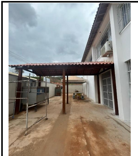
Figura 22 -Execução de madeiramento e de cobertura em telhas coloniais
