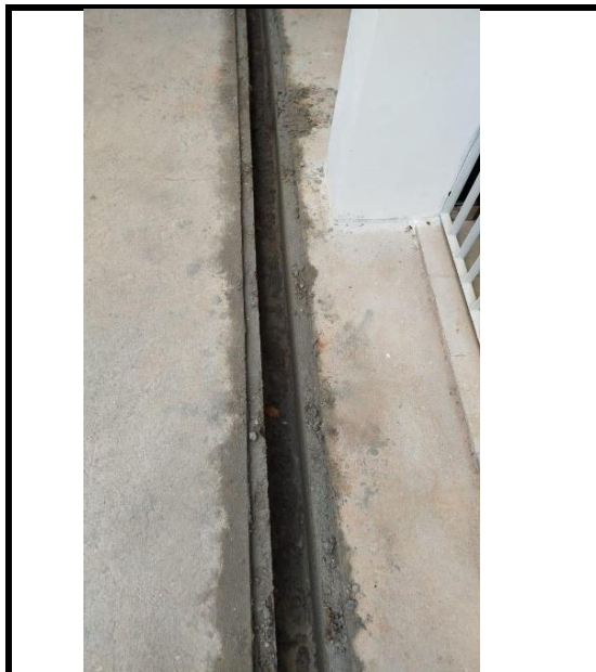
Figura 30- execução de canal autolimpanete com grelha
