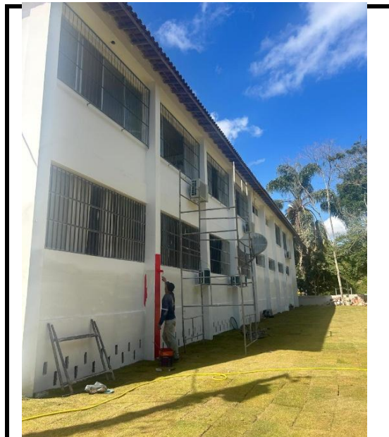
Figura 12 - Execução de pintura-exterior
