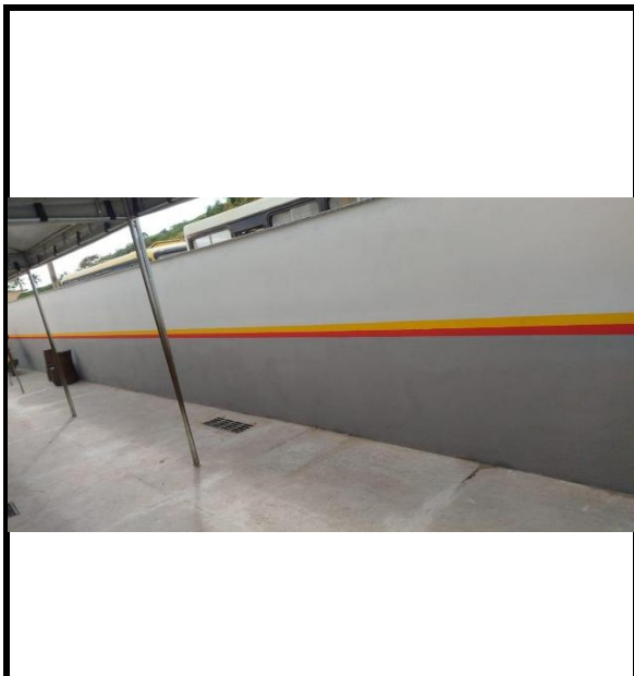
Figura 45-execução de pintura- muro frontal
