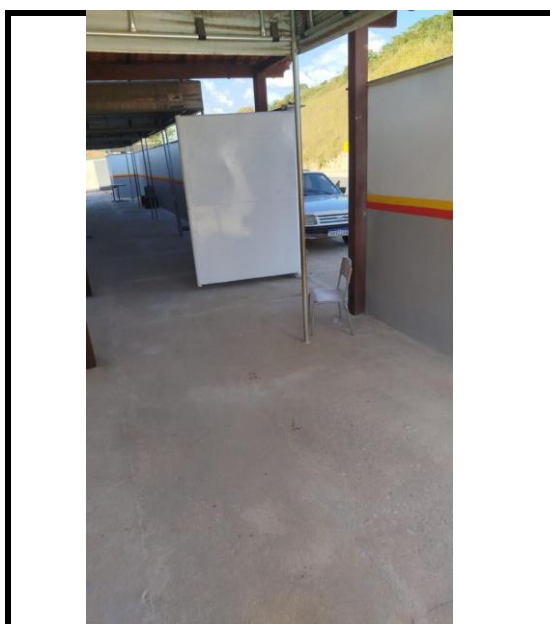
Figura 44 - execução de portões com chapa de aço
