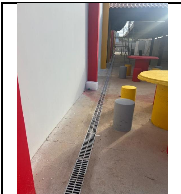
Figura 31 - execução de canal autolimpanete com grelha
