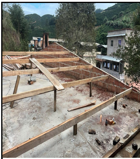
Figura 14 -Platibanda e estrutura de telhado
