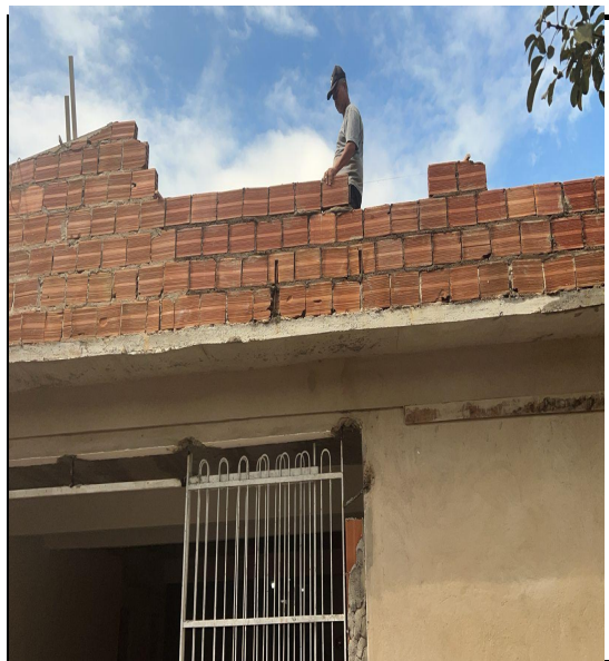
Figura 5 - Platibanda
