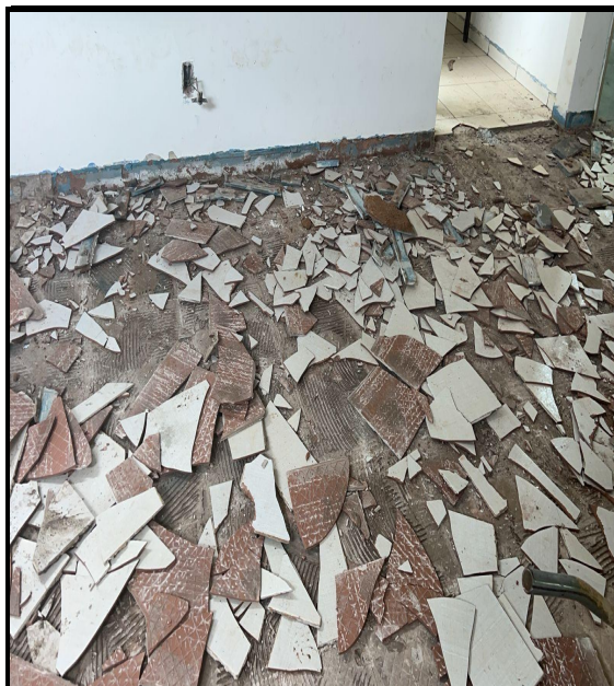
Figura 2 - Demolição de Piso
