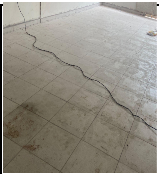
Figura 9 - Execução de piso e rodapé
