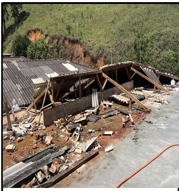
Figura 3 - Demolição de telhado
