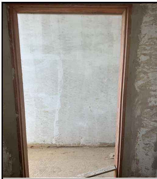
Figura 6 - Fornecimento e instalação de Marco
