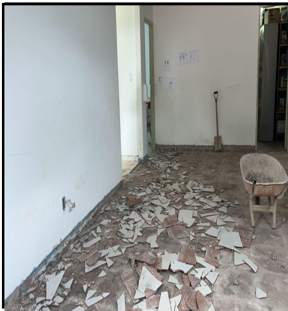
Figura 1 -Demolição de Piso
