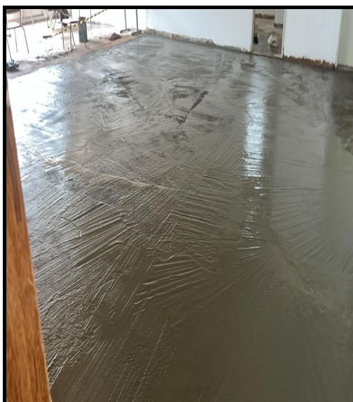
Figura 12 -Regularização de base para cerâmica
