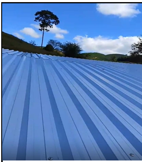
Figura 16 -Fornecimento e instalação de telha metálica
