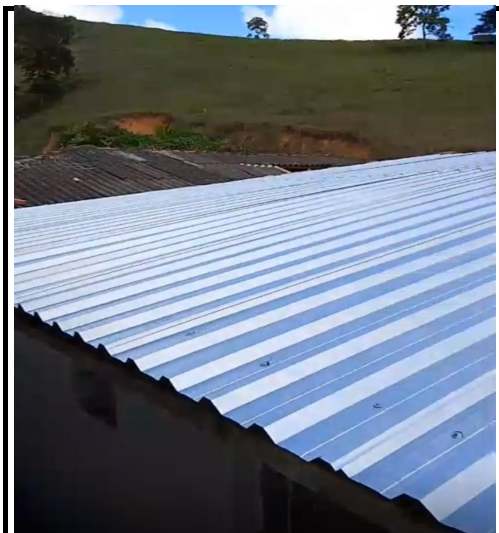
Figura 17 - Fornecimento e instalação de telha metálica
