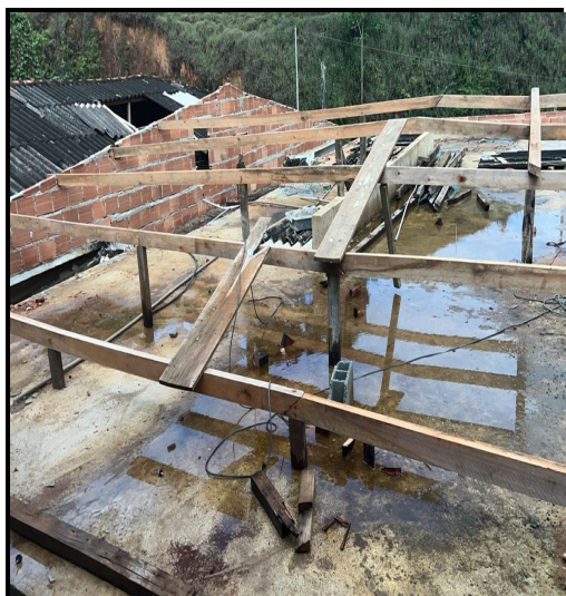
Figura 15 - Platibanda e estrutura de telhado
