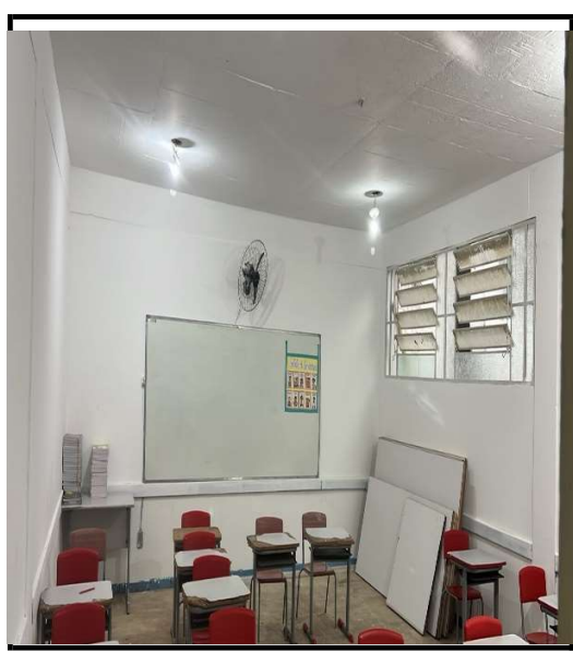
Figura 8 - Emassamento, lixamento e pintura de parede.
