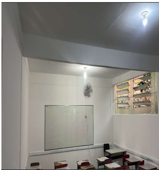
Figura 5 - Emassamento, lixamento e pintura de parede.
