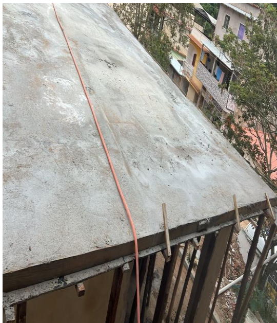
Figura 4 - concretagem laje cozinha
