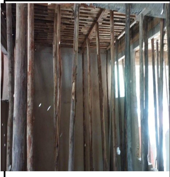
Figura 1 - Execução de escoras para laje
