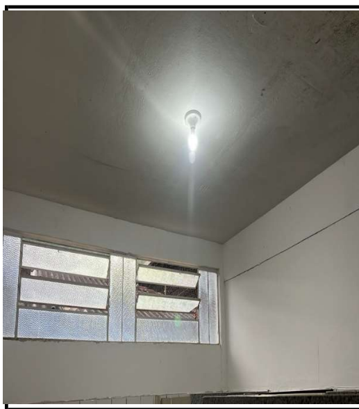
Figura 6 - Emassamento, lixamento e pintura de parede.
