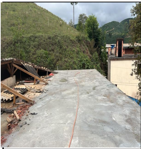
Figura 3 - concretagem laje cozinha.
