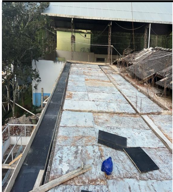
Figura 2 - Execução de Forma, laje cozinha
