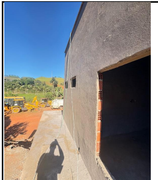
12.1.3 - Reboco tipo paulista de argamassa de cimento
