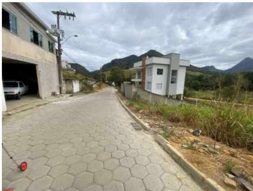
Execução de pavimentação com blocos sextavados de concreto. 13/08/2025.
