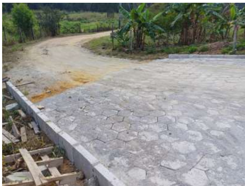
Execução de pavimentação com blocos sextavados de concreto. 24/07/2025.
