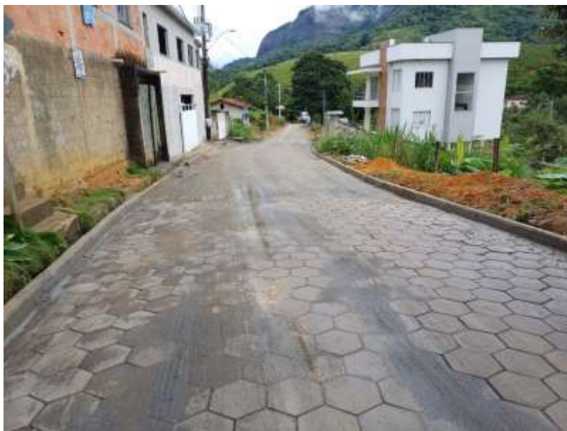
Execução de pavimentação com blocos sextavados de concreto. 08/05/2025.
