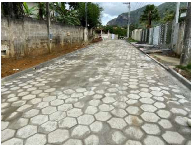
Pavimentação com blocos de concreto pré-moldados espessura 10 cm. 04/11/2024.
