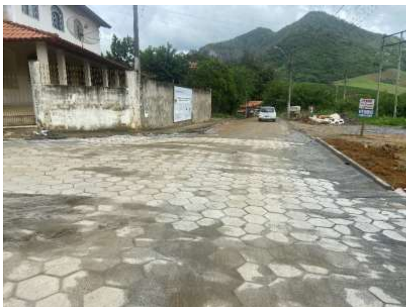
Fim do primeiro trecho de pavimentação. 04/11/2024.
