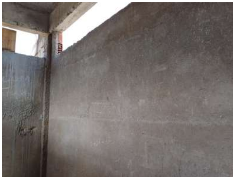
Execução de reboco em paredes.
