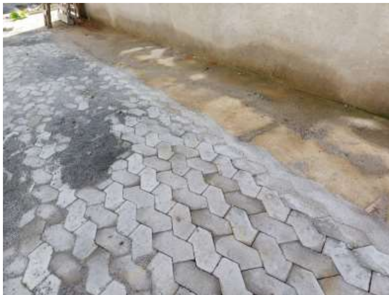
Execução de pavimentação do pátio.
