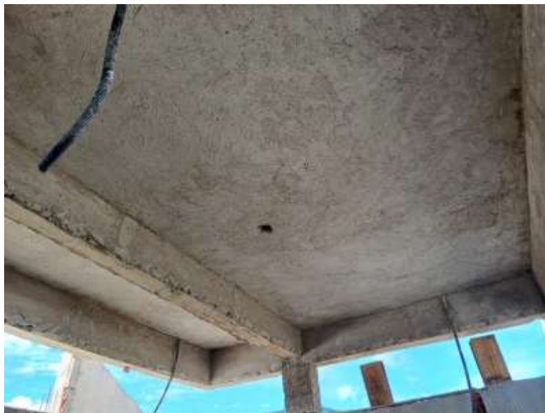
Execução de reboco no teto.
