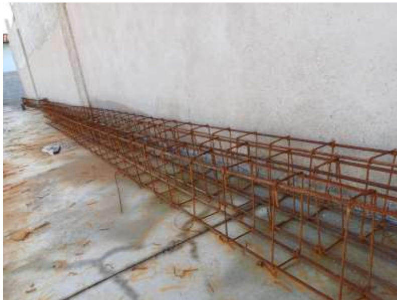
Montagem de ferragem para execução de vigas.
