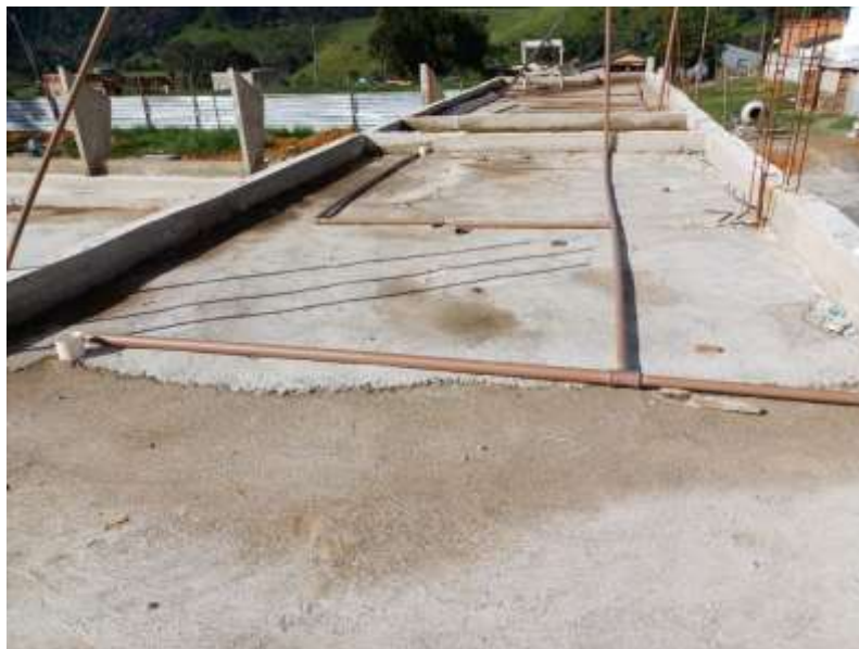
Execução de redes hidrossanitárias.
