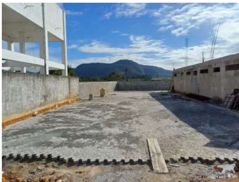
Execução de pavimentação do pátio.
