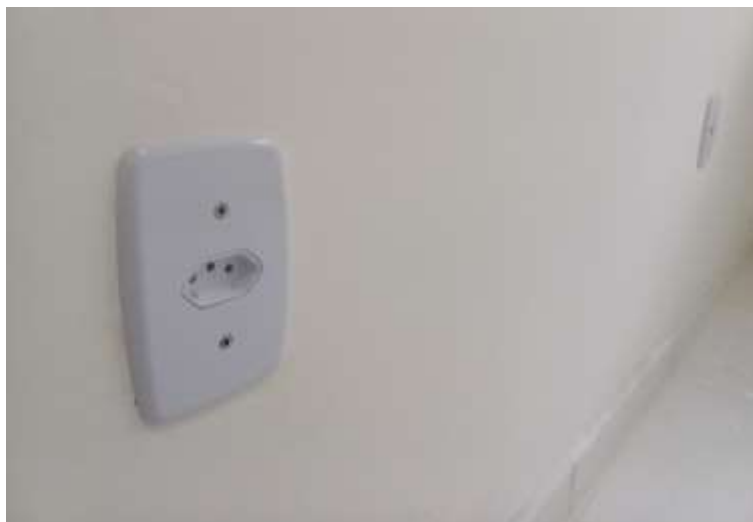
Instalação de pontos elétricos – 19/03/2024.
