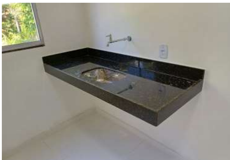
Instalação de pia e bancada de granito – 19/03/2024.
