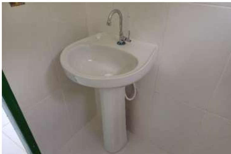
Instalação de lavatório e torneira – 19/03/2024.
