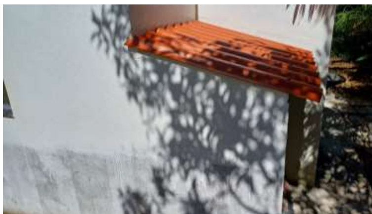
Execução da casa do compressor – 19/03/2024.
