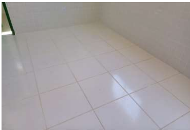
Execução de revestimento cerâmico em pisos internos – 19/03/2024.
