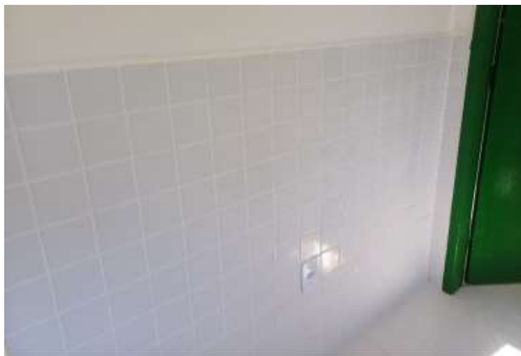
Execução de revestimento cerâmico em paredes internas – 19/03/2024.
