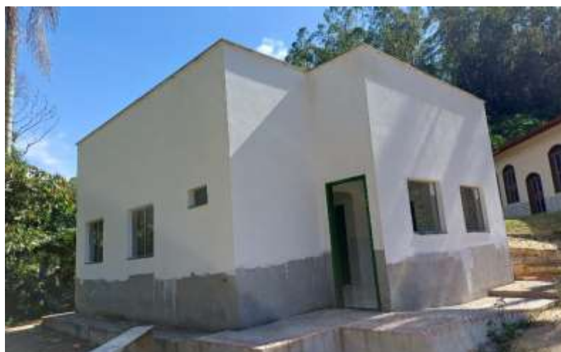
Execução de pintura externa – 19/03/2024.
