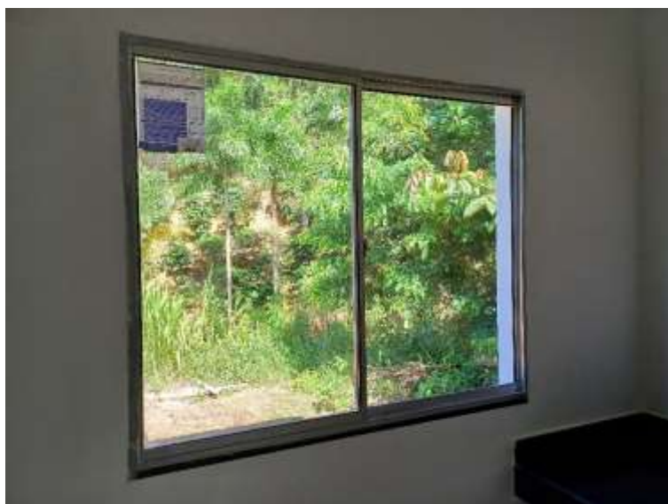
Instalação de janelas de alumínio e vidro – 19/03/2024.
