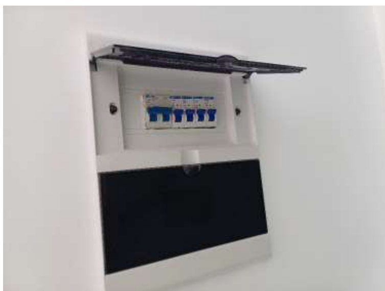
Instalação de quadro de disjuntores – 19/03/2024.
