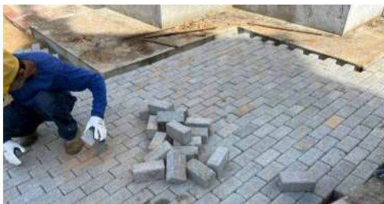
Execução da pavimentação no pátio – 19/03/2024.
