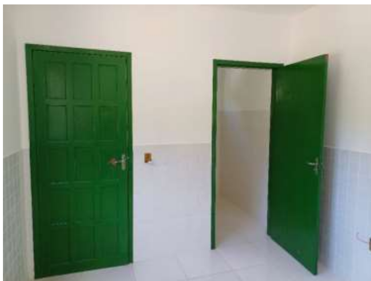
Instalação e pintura de esquadrias de madeira – 19/03/2024.
