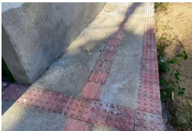
Assentamento de piso tátil de alerta na rampa – 19/03/2024.
