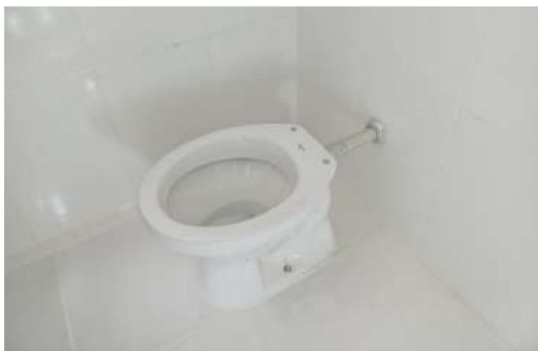
Instalação de vaso sanitário – 19/03/2024.
