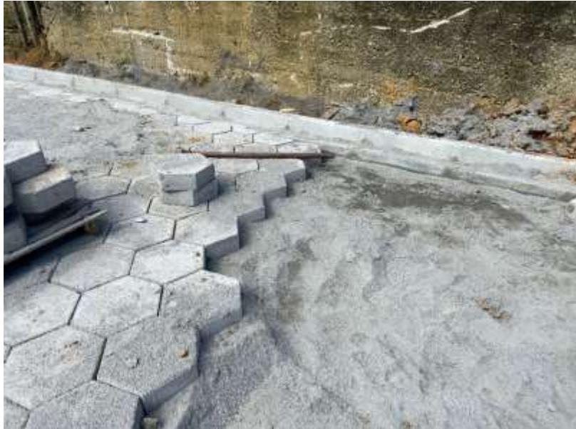
Pavimentação com blocos de concreto pré-moldados espessura 10 cm. 02/10/2024.
