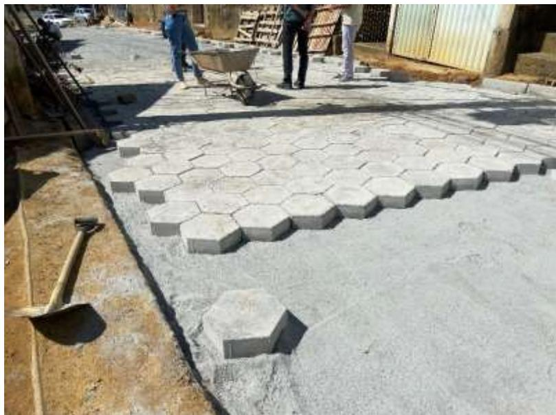
Pavimentação com blocos de concreto pré-moldados espessura 10 cm. 26/09/2024.
