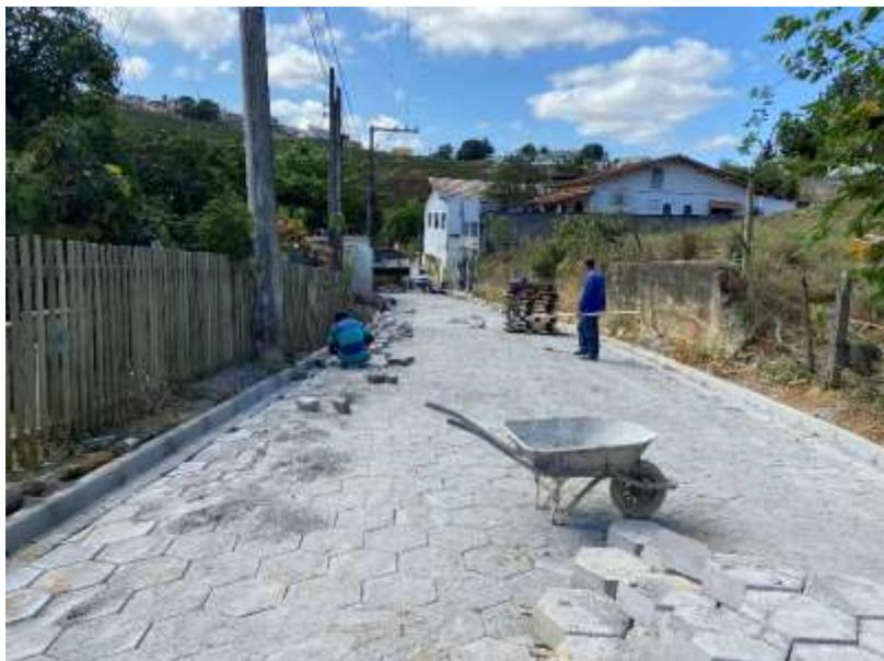
Pavimentação com blocos de concreto pré-moldados espessura 10 cm em execução. 02/10/2024.
