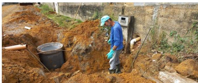
Os PVs 34 a 41 foram executados na via e serão suspensos quando a mesma for pavimentada
