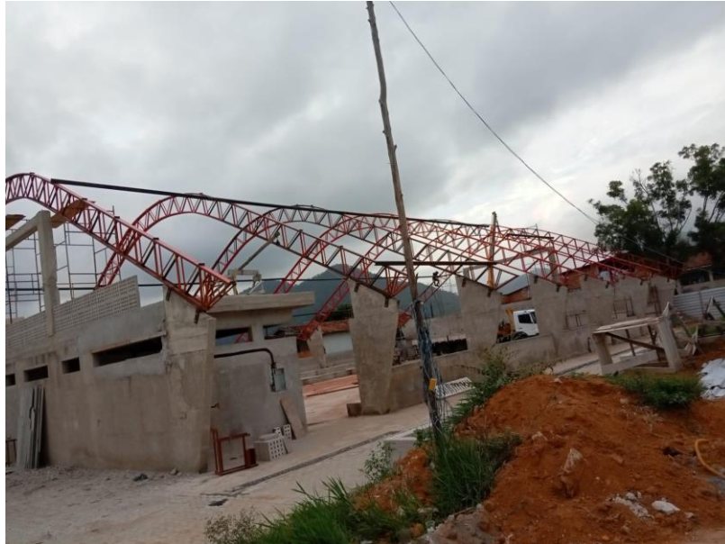
Foto 02 – vigas metálicas – área interna da quadra – ano 2025 – Arquivo Pessoal
