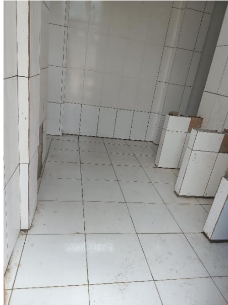
Foto 04 – vestiário masculino – revestimento paredes e piso– ano 2025 – Arquivo Pessoal
