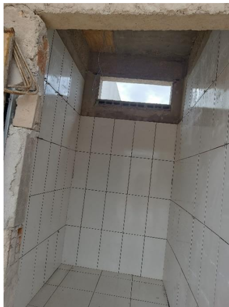
Foto 05 – deposito – revestimento paredes e piso– ano 2025 – Arquivo Pessoal
