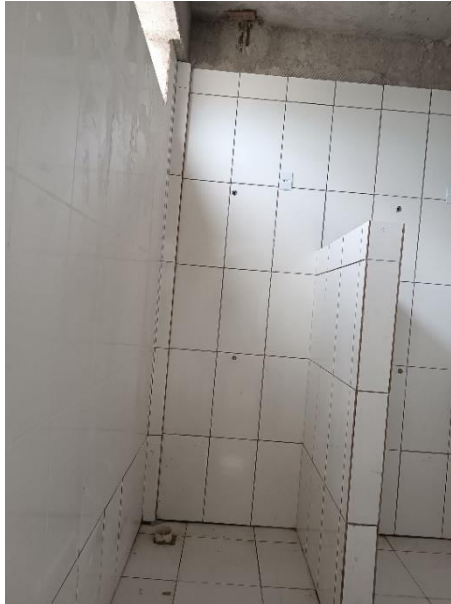
Foto 6 – vestiário feminino – revestimento paredes e piso– ano 2025 – Arquivo Pessoal
