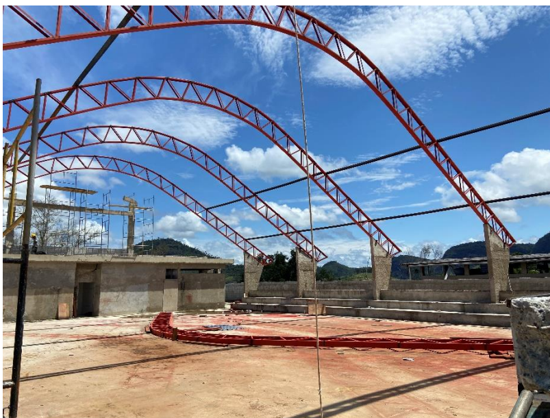
Foto 01 – vigas metálicas – área interna da quadra – ano 2025 – Arquivo Pessoal
