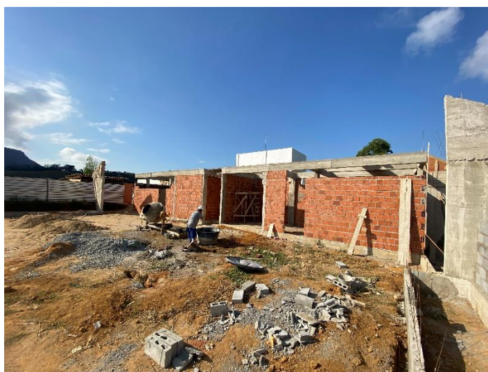
Execução dos pilares de concreto – 26/06/2024.
