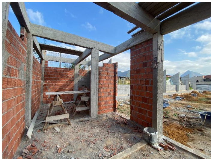
Montagem das ferragens – 26/06/2024.
