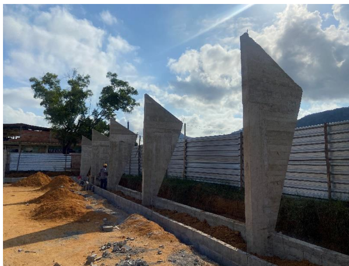
Execução de fôrmas – 26/06/2024.
