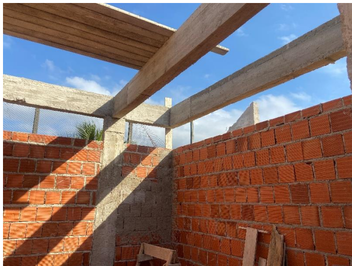
Concretagem de vigas baldrame e pilares – 26/06/2024.
