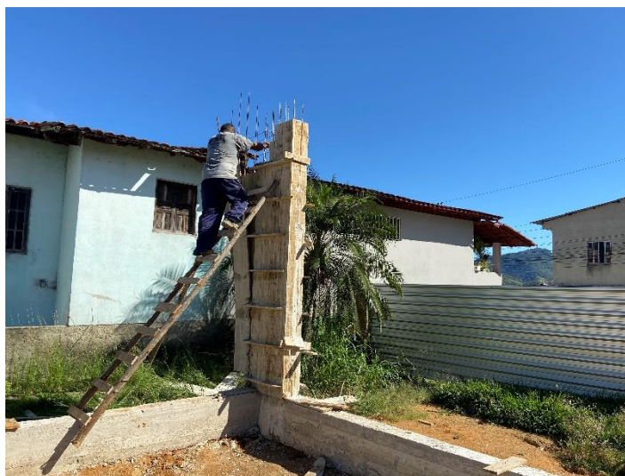
Execução de fôrmas – 26/06/2024.
