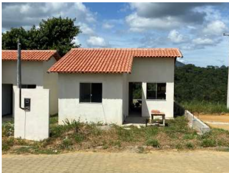
Construção de unidade habitacional adaptada para PNE. Em 17/04/2024.
