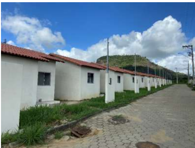
Construção de casas populares. Em 17/04/2024.
