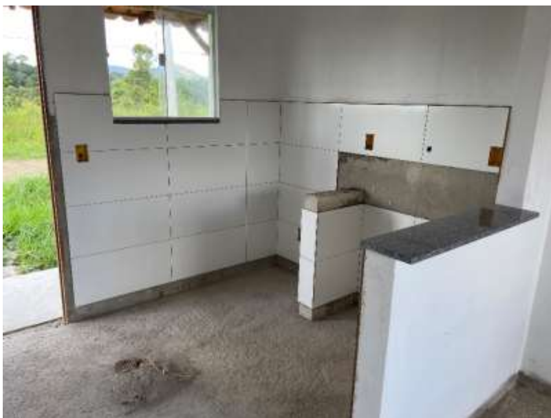
Revestimento de parede com cerâmica. Em 17/04/2024.
