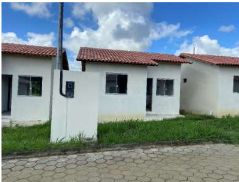
Construção de casas populares. Em 17/04/2024.
