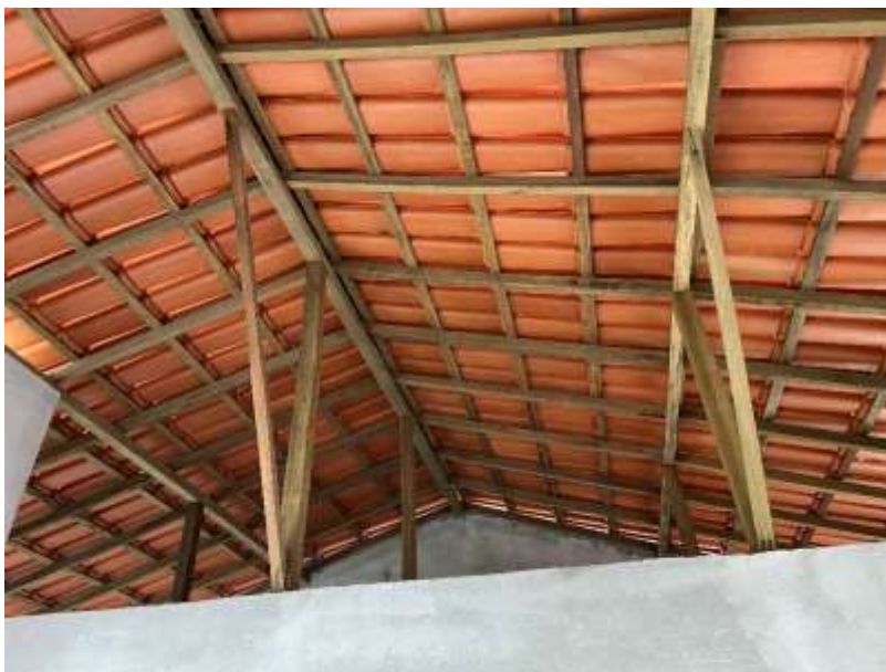
Cobertura com estrutura de madeira e telhas cerâmicas. Em 17/04/2024.
