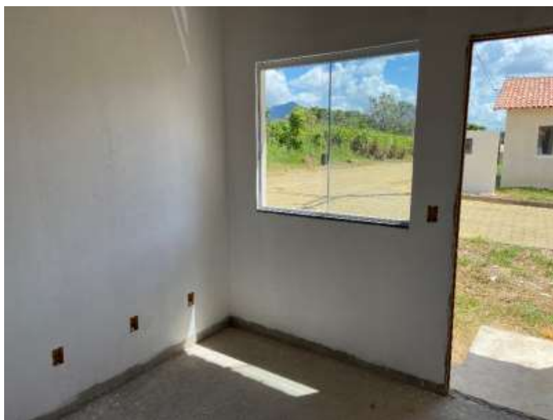
Revestimento de parede com pintura sobre reboco e janela em vidro e alumínio. Em 17/04/2024.
