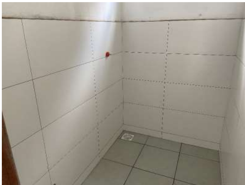
Revestimento de parede e piso com cerâmica. Em 17/04/2024.
