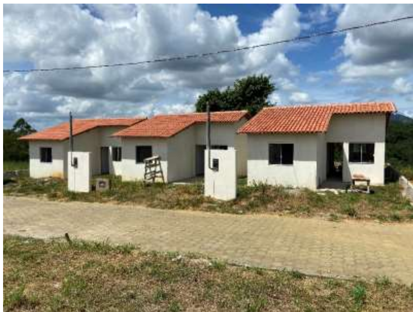
Construção de 03 unidades habitacionais adaptadas para PNE. Em 17/04/2024.
