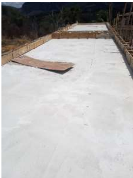
Laje pré-moldada de concreto, formas de madeira e armadura – 17/09/2024.
