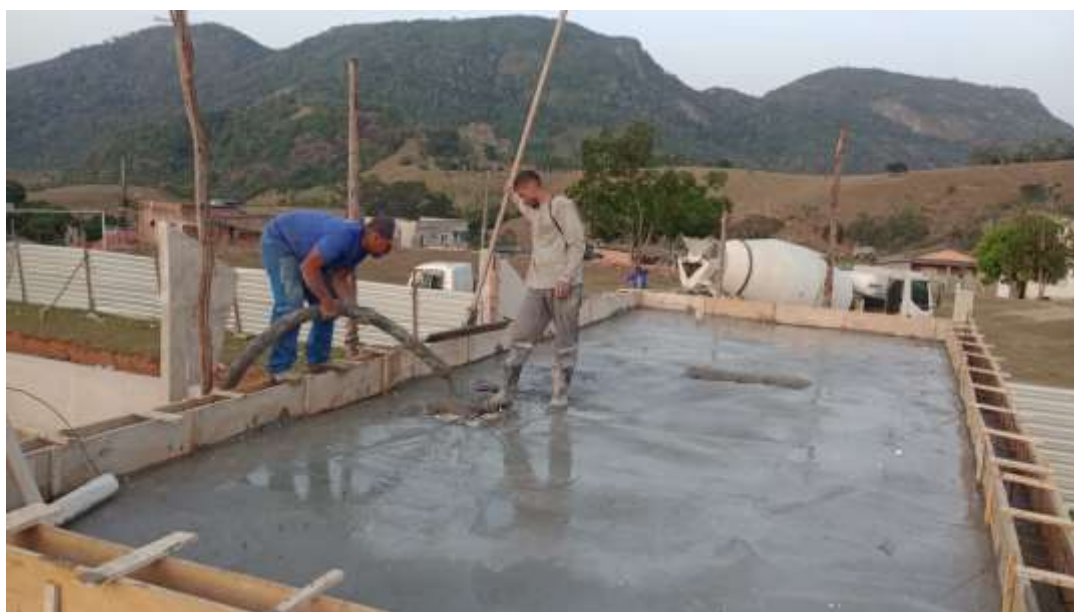
Concretagem de laje pré-moldada de concreto, formas de madeira e armadura – 13/09/2024.
