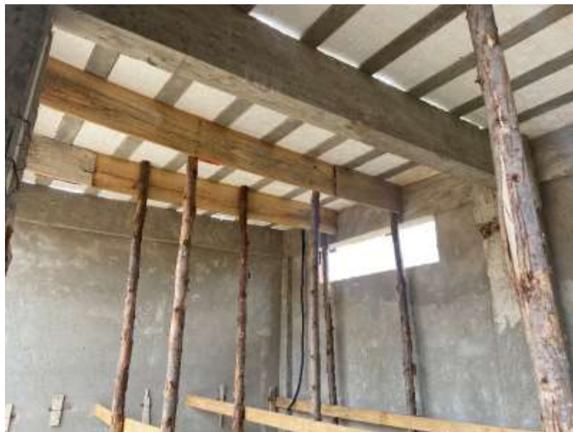
Montagem de laje pré-moldada – 27/08/2024.
