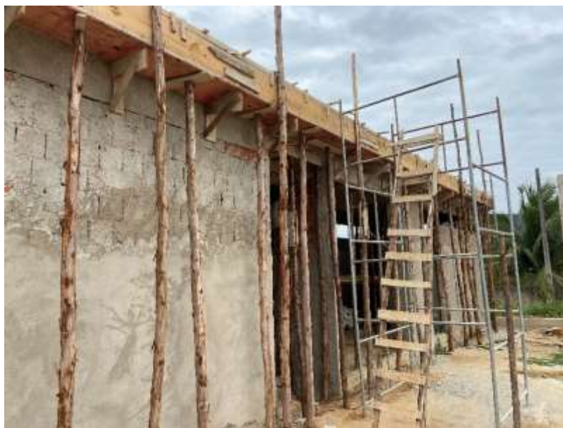
Execução de fôrmas – 27/08/2024.
