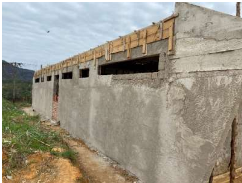
Revestimento de parede com chapisco e emboço – 27/08/2024.
