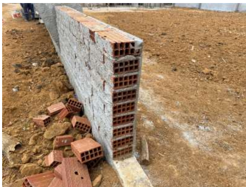
Execução de alvenaria com espessura de 20cm e chapisco – 27/08/2024.
