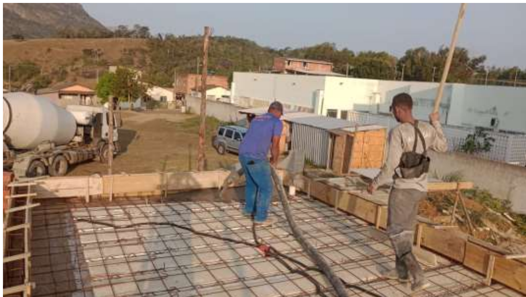
Execução de laje pré-moldada de concreto, formas de madeira e armadura – 13/09/2024.
