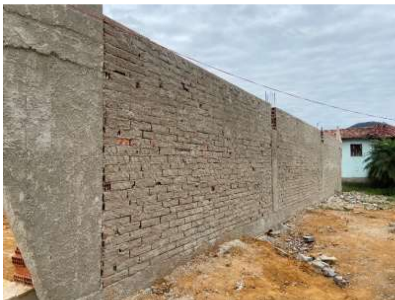
Revestimento de parede com chapisco – 27/08/2024.
