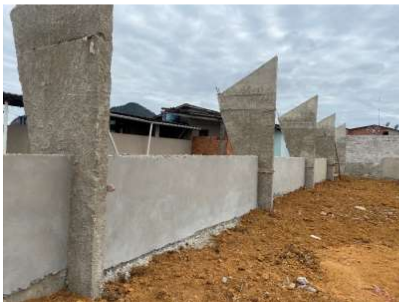
Revestimento de parede com chapisco e reboco – 27/08/2024.
