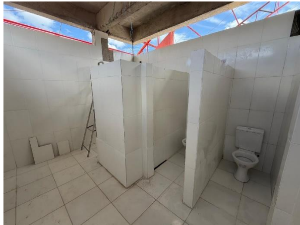
Foto 03 – Vaso sanitário – ano 2026 – Arquivo Pessoal
