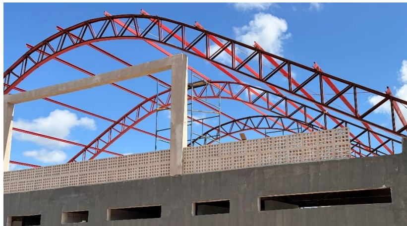
Foto 03 – Cobogó de concreto – ano 2026 – Arquivo Pessoal
