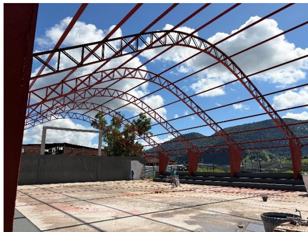
Foto 01 – estruturas metálicas – área interna da quadra – ano 2026 – Arquivo Pessoal
