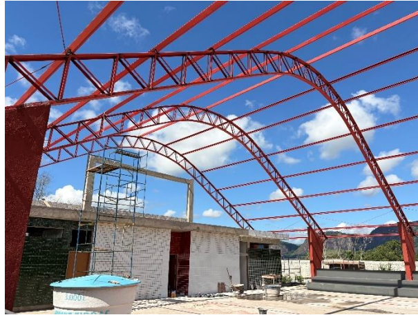
Foto 02 – estruturas metálicas – área interna da quadra – ano 2025 – Arquivo Pessoal
