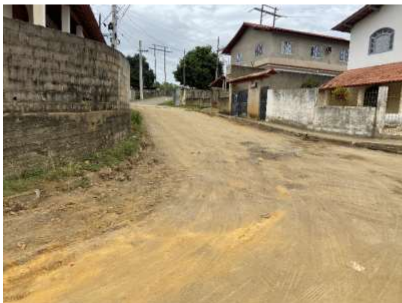
Remoção de pavimentação de paralelepípedos.
