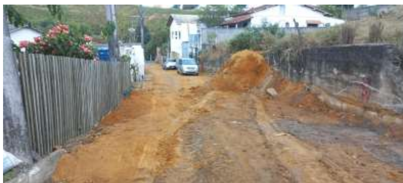
Escavação e retirada de terra para nivelamento da área a ser pavimentada.
