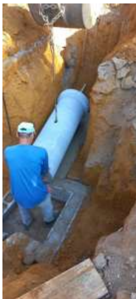
Escavação e assentamento de rede de drenagem diâmetro 40cm.
