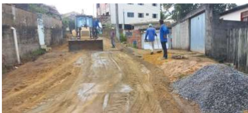
Regularização da área a ser pavimentada.
