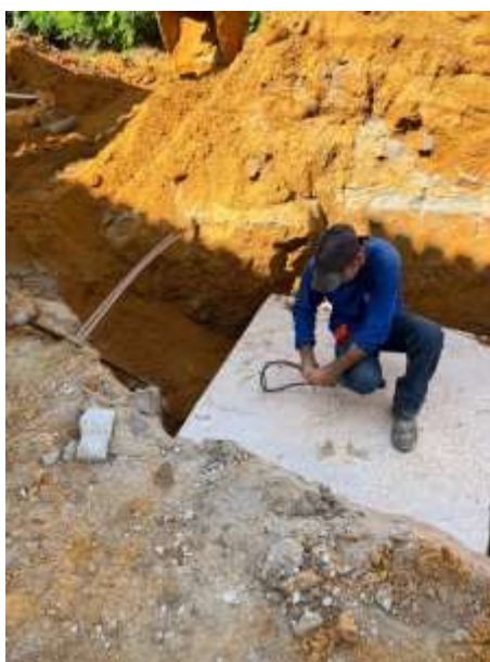
Assentamento de tampa cega em caixa de passagem para rede de drenagem diâmetro 40cm.
