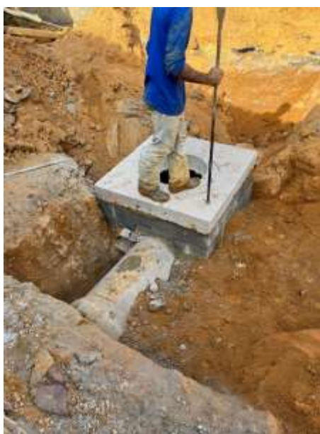
Execução de poços de visita para rede de drenagem diâmetro 40cm.
