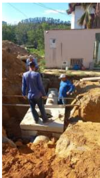
Instalação de poços de visita para rede de drenagem diâmetro 40cm.
