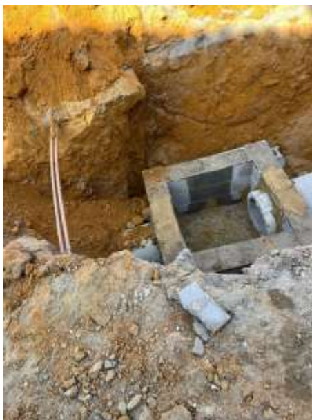
Execução de caixa de passagem para rede de drenagem diâmetro 40cm.
