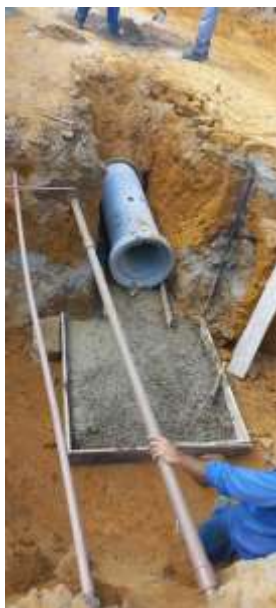
Execução de poços de visita para rede de drenagem diâmetro 40cm.
