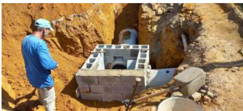
Execução de poços de visita para rede de drenagem diâmetro 40cm.
