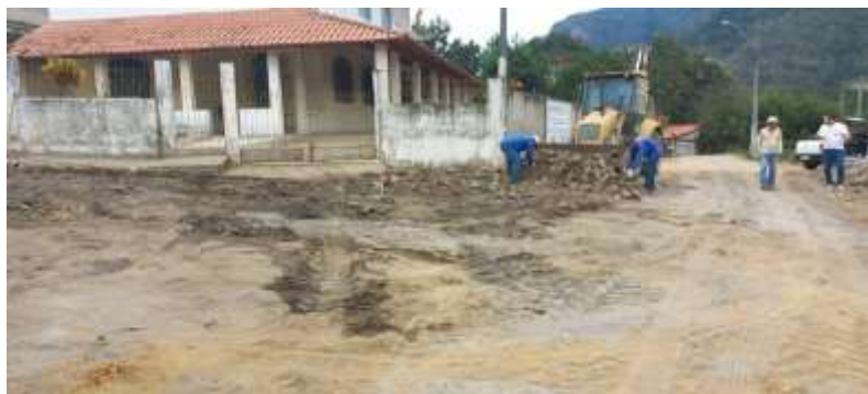
Remoção de pavimentação de paralelepípedos.
