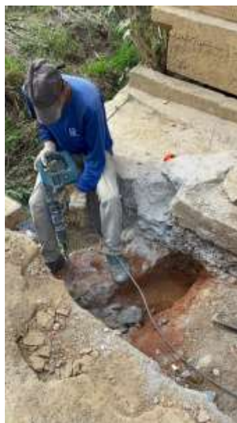
Demolição de concreto para passagem de tubulação de drenagem.
