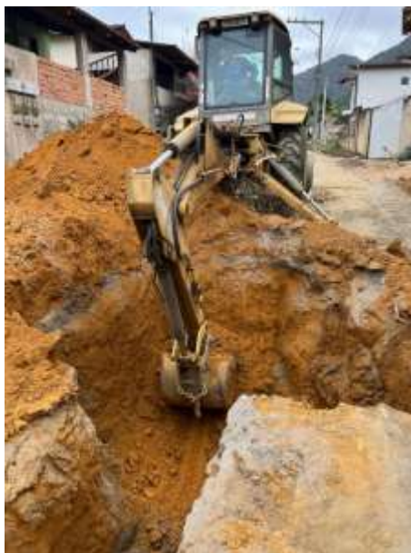
Escavação para assentamento de rede de drenagem diâmetro 40cm.
