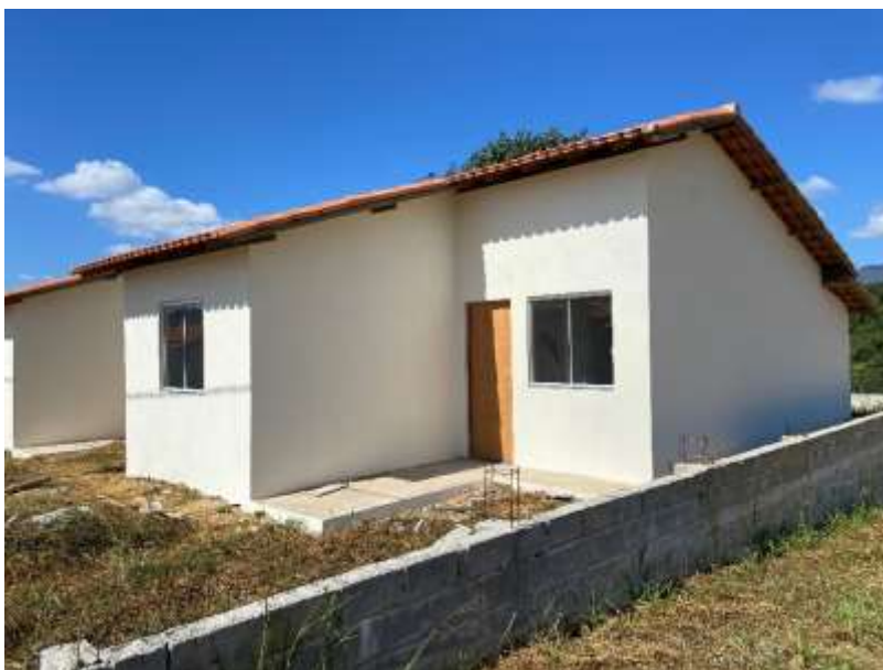
Construção de 03 unidades habitacionais adaptadas para PNE. Em 22/07/2024.
