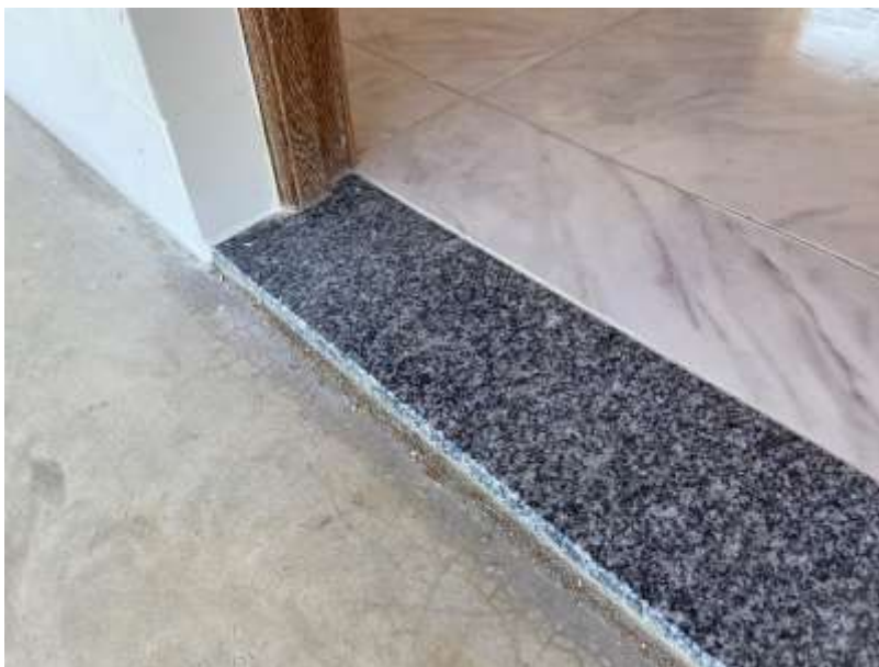
Soleira em granito cinza, piso interno cerâmico e externo de cimento. Em 22/07/2024.
