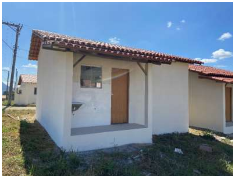
Área de serviço, revestimento de parede com cerâmica. Em 22/07/2024.
