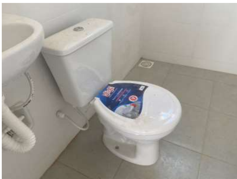
Vaso sanitário com caixa acoplada em louça branca. Em 22/07/2024.
