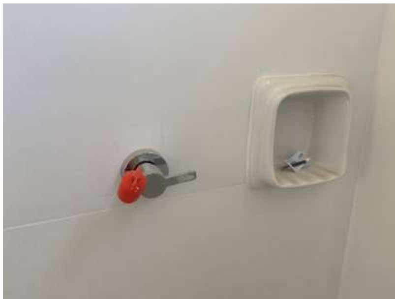
Registro de pressão com acabamento cromado e saboneteira de louça branca. Em 22/07/2024.
