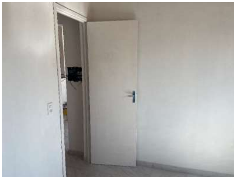
Porta interna, revestimento de parede com pintura sobre reboco e rodapé cerâmico. Em 22/07/2024.
