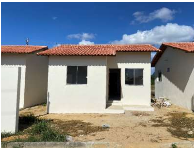
Construção de casas populares. Em 17/04/2024. Em 22/07/2024.
