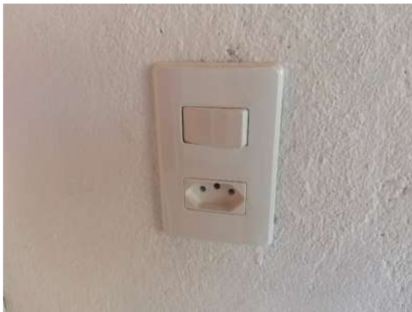
Tomada e interruptor. Em 22/07/2024.
