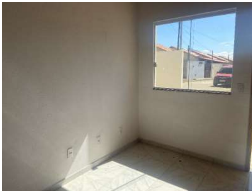
Revestimento de parede com pintura sobre reboco, rodapé cerâmico e janelas em vidro temperado. Em 22/07/2024.
