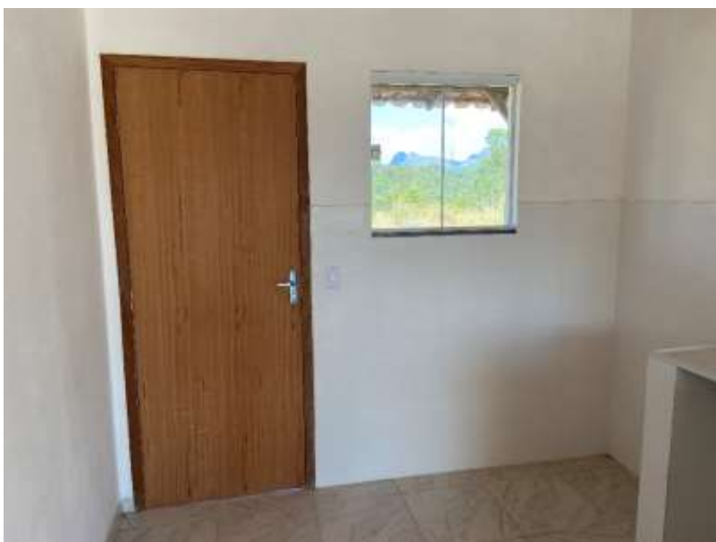
Porta externa, revestimento de piso e parede. Em 22/07/2024.
