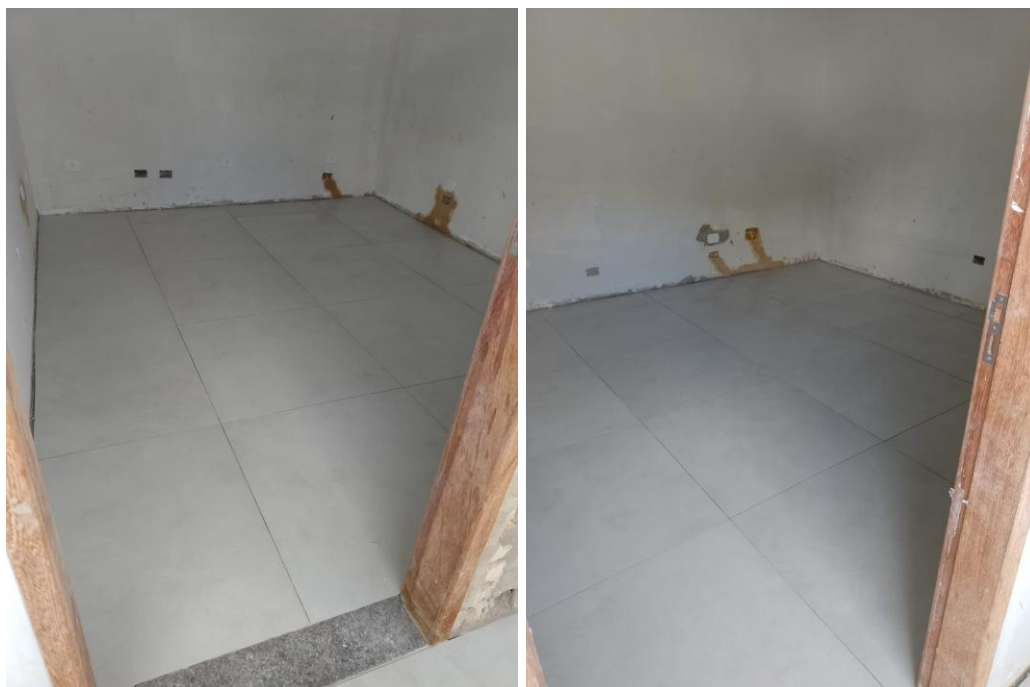
Figuras 15 e 16 – Item 10.08 - Porcelanato esmaltado, acabamento acetinado, dim. 60x60cm, ref. de cor CIMENTO CINZA BOLD Portobello/equiv, utilizando dupla colagem de argamassa colante para porcelanato tipo ACIII e rejunte 3mm.
