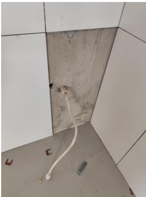
Figura 19 e 20 – Item 12.09 – Ponto de água fria (lavatório, tanque, pia de cozinha, etc...).
