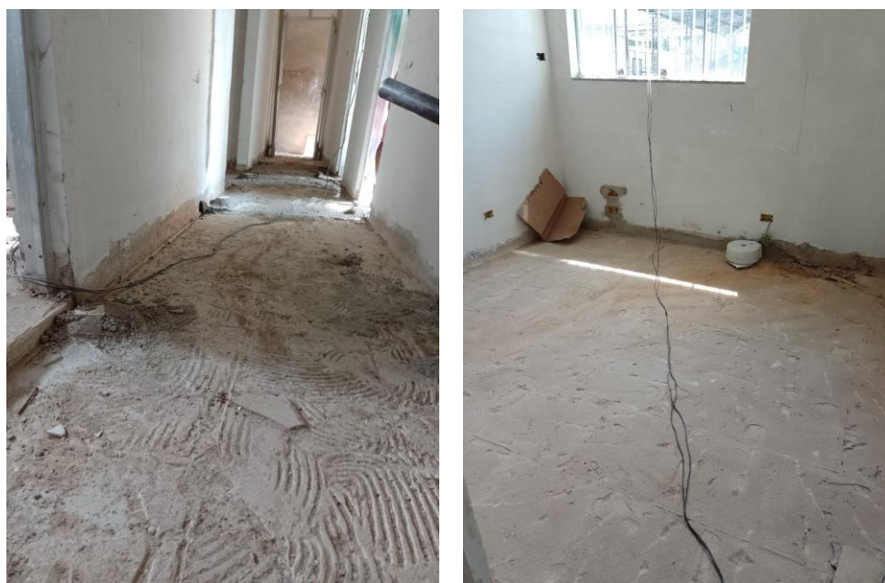
Figuras 1 e 2 - Item 02.01 – Demolição de piso revestido com cerâmica.
