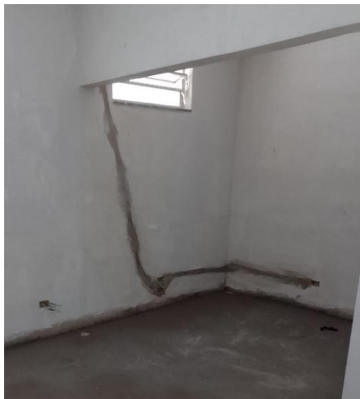
Figuras 4 e 5 – item 02.18 - Abertura e fechamento de rasgos em concreto, para passagem de eletroduto diâm. 2 1/2" a 4".
