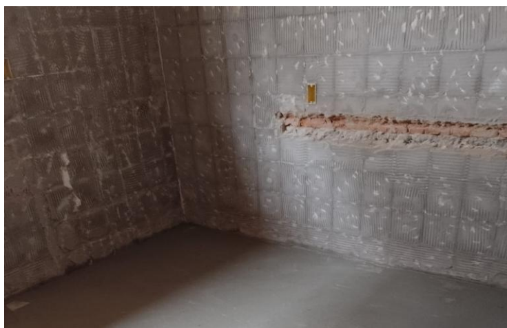
Figura 3 – Itens 02.02 e 02.03 - Retirada de revestimento antigo em reboco; Demolição de revestimento com azulejos.
