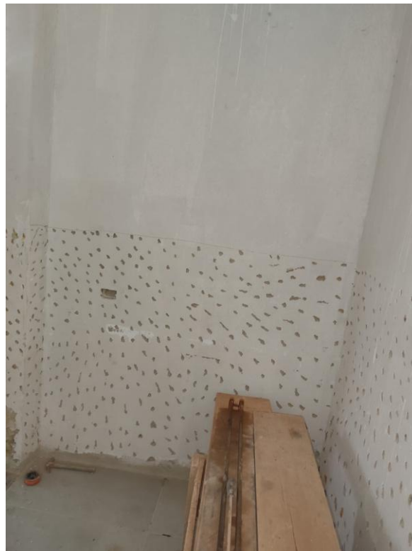
Figuras 6 e 7 – Item 02.19 – Apicoamento de superfície com revestimento em argamassa.
