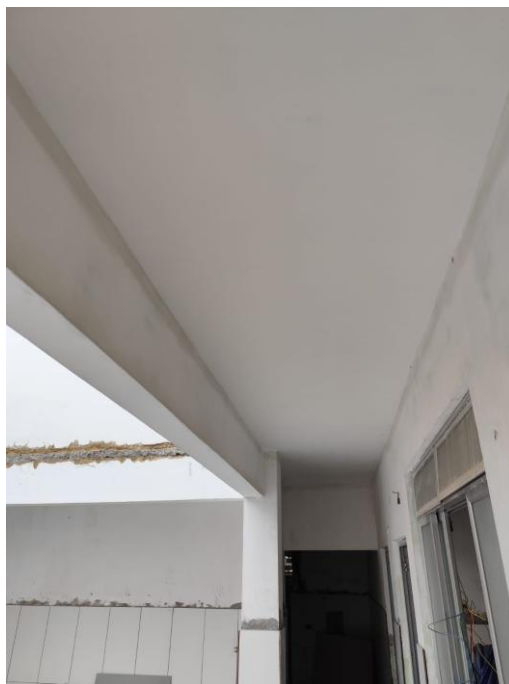
Figura 14 – Itens 09.05, 09.06 e 17.05 - Forro de gesso acabamento tipo liso; TRAMA DE AÇO COMPOSTA POR RIPAS PARA ESTRUTURA DE GESSO LISO, INCLUSO TRANSPORTE VERTICAL. AF_07/2019; Pintura em paredes e forros, aplicação manual, com três demãos de tinta látex premium, referência Suvinil, Coral e Metalatex, inclusive uma demão de líquido selador PVA, referência Suvinil, Coral ou Metalatex ou equivalente.
