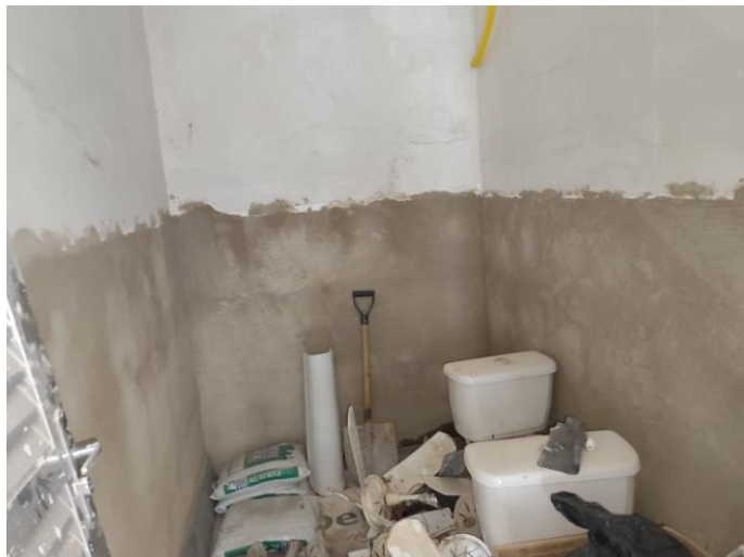
Figura 17 e 18 – Itens 11.01, 11.02 e 11.03 – Chapisco de argamassa de cimento e areia média ou grossa lavada, no traço 1:3, espessura 5 mm; Reboco tipo paulista de argamassa de cimento, cal hidratada CH1 e areia média ou grossa lavada no traço 1:0.5:6, espessura 25 mm; Emboço de argamassa de cimento, cal hidratada CH1 e areia média ou grossa lavada no traço 1:0.5:6, espessura 20 mm.
