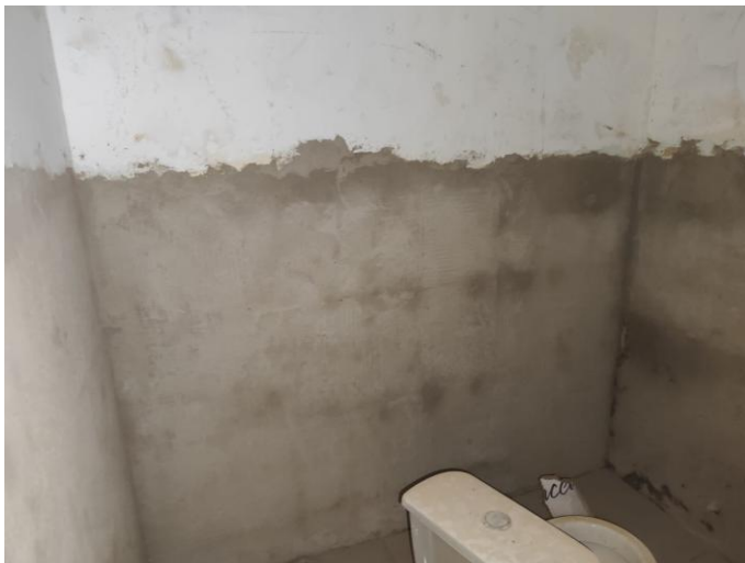
Figura 17 e 18 – Itens 11.01, 11.02 e 11.03 – Chapisco de argamassa de cimento e areia média ou grossa lavada, no traço 1:3, espessura 5 mm; Reboco tipo paulista de argamassa de cimento, cal hidratada CH1 e areia média ou grossa lavada no traço 1:0.5:6, espessura 25 mm; Emboço de argamassa de cimento, cal hidratada CH1 e areia média ou grossa lavada no traço 1:0.5:6, espessura 20 mm.
