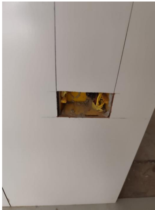
Figuras 25 e 26 - Item 13.03 - Ponto padrão de tomada 2 pólos mais terra - considerando eletroduto PVC rígido de 3/4" inclusive conexões (5.0m), fio isolado PVC de 2.5mm 2 (16.5m) e caixa pvc 4x2" (1 und).
