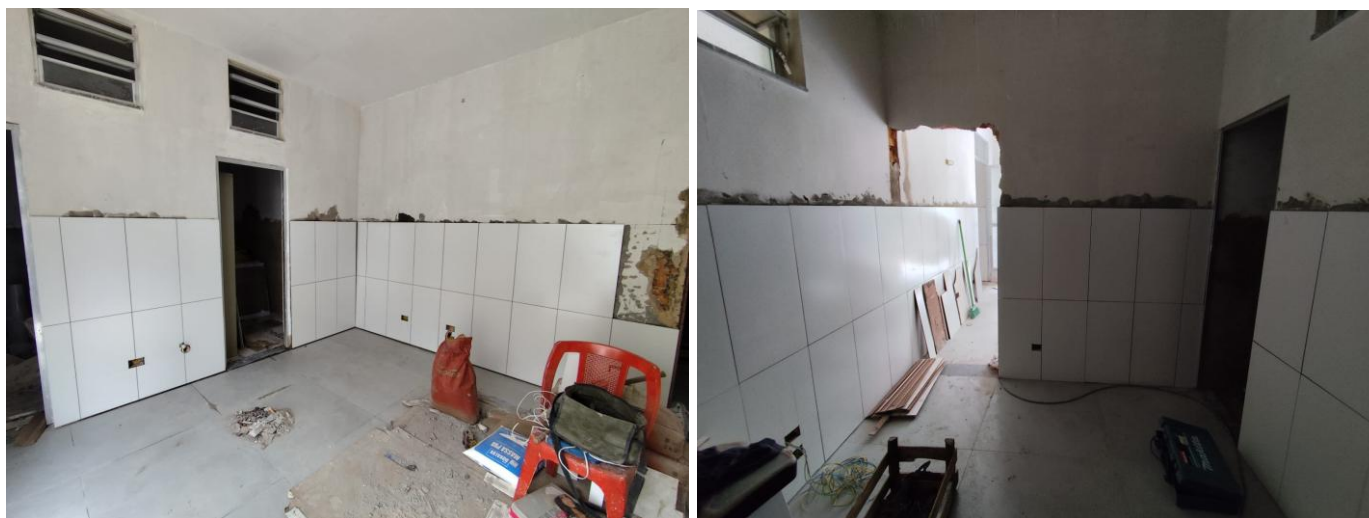
Figuras 2 e 13 – Itens 09.04 e 10.05 – Emassamento de paredes e forros, com duas demãos de massa corrida, referência Suvinil, Coral, Metalatex ou equivalente, inclusive uma demão de líquido selador PVA, referência Suvinil, Coral ou Metalatex ou equivalente; Piso cerâmico esmaltado, PEI 5, acabamento semibrilho, dim. 45x45cm, ref. de cor CARGO PLUS WHITE Eliane/equiv. assentado com argamassa de cimento colante, inclusive rejuntamento.
