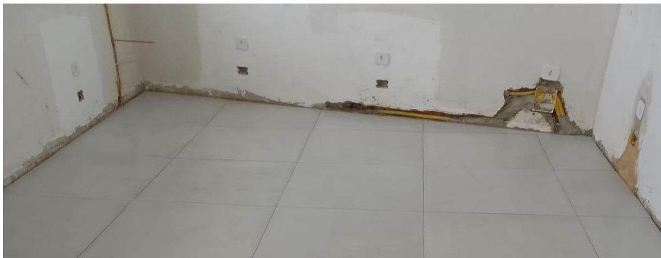
Figuras 33 e 34 - Item 13.13, 14.01, 14.08 e 14.10 – Eletroduto de PVC rígido roscável, diâm. 1" (32mm), inclusive conexões; Eletroduto de PVC rígido roscável, diâm. 1" " (32mm), inclusive conexões; Eletroduto de PVC rígido roscável, diâm. 1 1/2" (50mm), inclusive conexões m 36,70; Eletroduto de PVC rígido roscável, diâm. 1/2" (20mm), inclusive conexões m 15,90.
