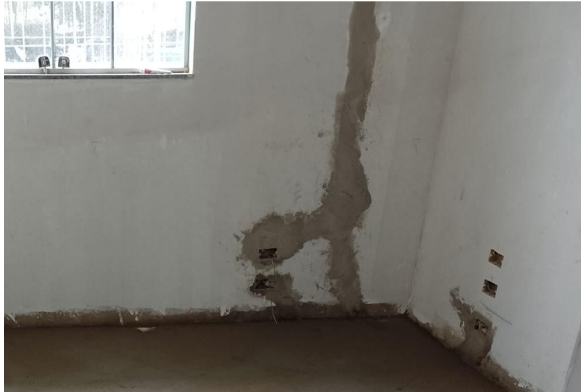
Figuras 4 e 5 – item 02.18 - Abertura e fechamento de rasgos em concreto, para passagem de eletroduto diâm. 2 1/2" a 4".
