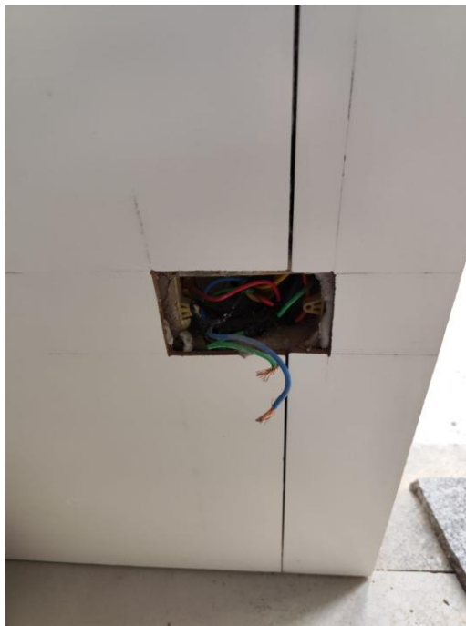
Figuras 25 e 26 - Item 13.03 - Ponto padrão de tomada 2 pólos mais terra - considerando eletroduto PVC rígido de 3/4" inclusive conexões (5.0m), fio isolado PVC de 2.5mm 2 (16.5m) e caixa pvc 4x2" (1 und).
