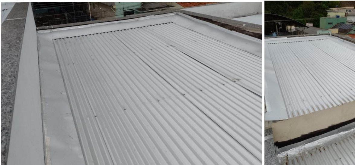
Figuras 10 e 11 – Item 07.09 - Cobertura nova de telhas de alumínio trapezoidal, H = 8 cm, esp. 0.5mm, inclusive acessórios de fixação.
