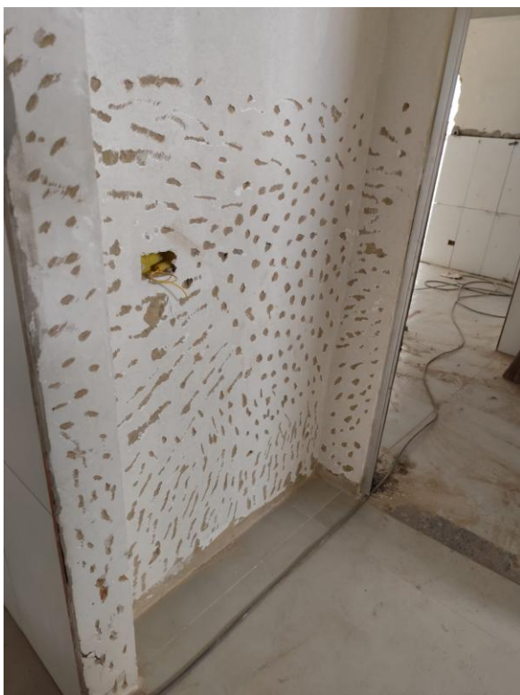
Figuras 6 e 7 – Item 02.19 – Apicoamento de superfície com revestimento em argamassa.
