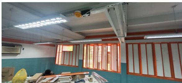
Fotos 91 e 92 7.15.1 luminaria sobrepor compl., corpo ch. aço pintada branca, refletor, aletas parabólicas alum. alta pureza e refletância inclusive 2 lâmpadas led t8 9/10w temp. de cor 5000k c/ 60cm - ref. cs216al-n - ames, 1261 - lumavi ou equivalente
