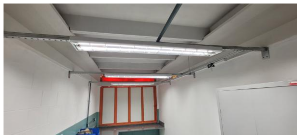
Fotos 91 e 92 7.15.1 luminaria sobrepor compl., corpo ch. aço pintada branca, refletor, aletas parabólicas alum. alta pureza e refletância inclusive 2 lâmpadas led t8 9/10w temp. de cor 5000k c/ 60cm - ref. cs216al-n - ames, 1261 - lumavi ou equivalente
