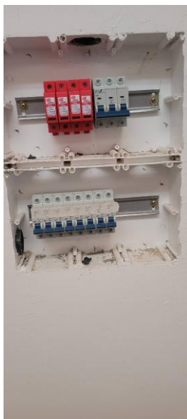
Foto 39 Item 7.2.1 Quadro de distribuição de sobrepor, em resina termoplástica, para até 08 disjuntores, sem barramento, padrão DIN, exclusive disjuntores
