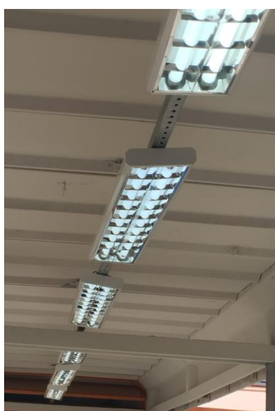
Fotos 91 e 92 7.15.1 luminaria sobrepor compl., corpo ch. aço pintada branca, refletor, aletas parabólicas alum. alta pureza e refletância inclusive 2 lâmpadas led t8 9/10w temp. de cor 5000k c/ 60cm - ref. cs216al-n - ames, 1261 - lumavi ou equivalente
